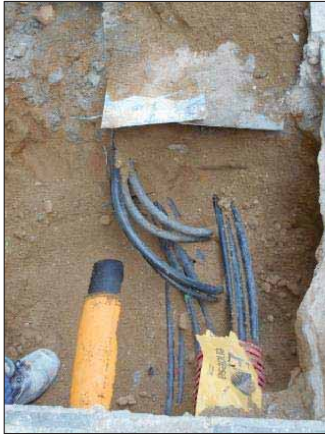
37. Treballs d'obertura en rasa al carrer de Sostres.
