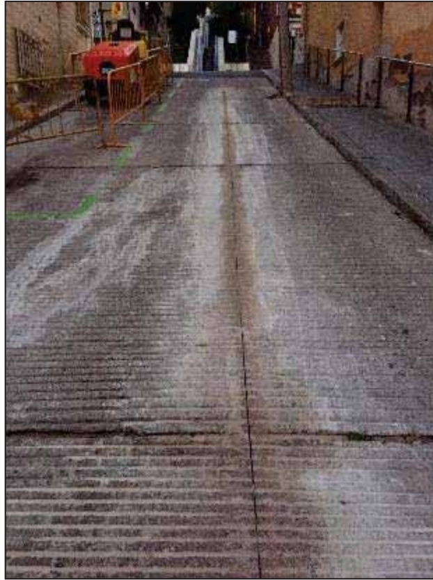
49. Retall fet al carrer per extreure el paviment i poder realitzar la rasa.
