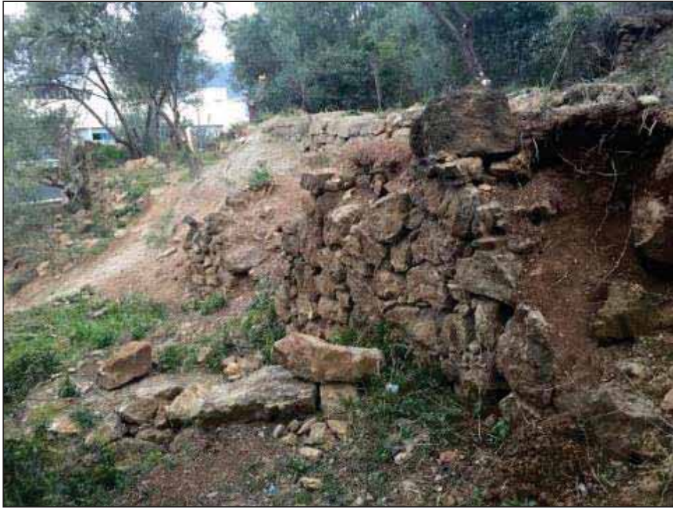
13. Murs de contenció de terres.
