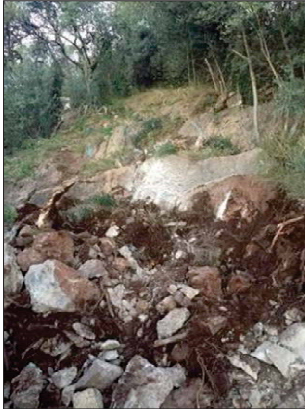
9. Zona de construcció del camí, on aflora la roca natural.
