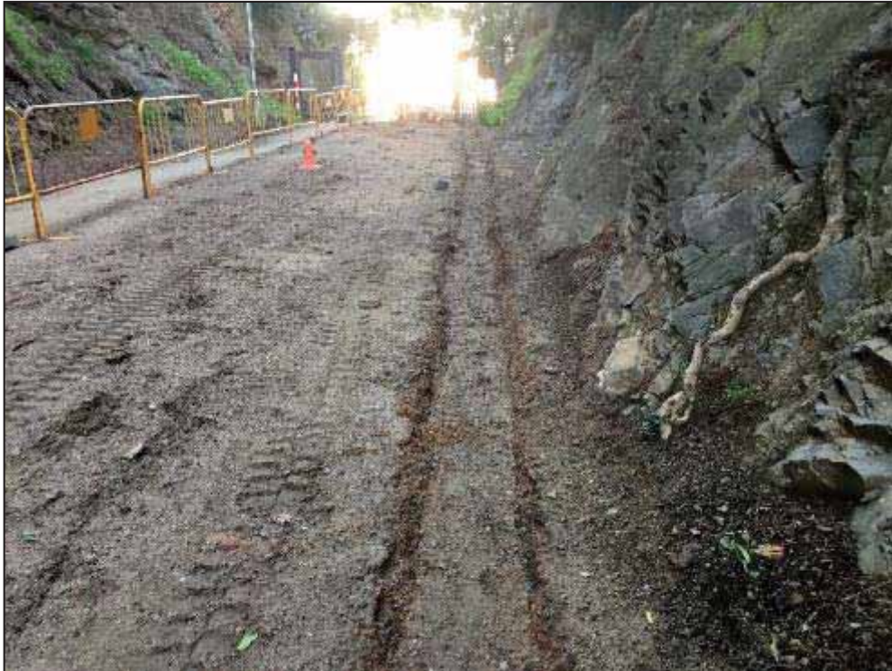
19. Rasa nord Forat del Vent acabada.
