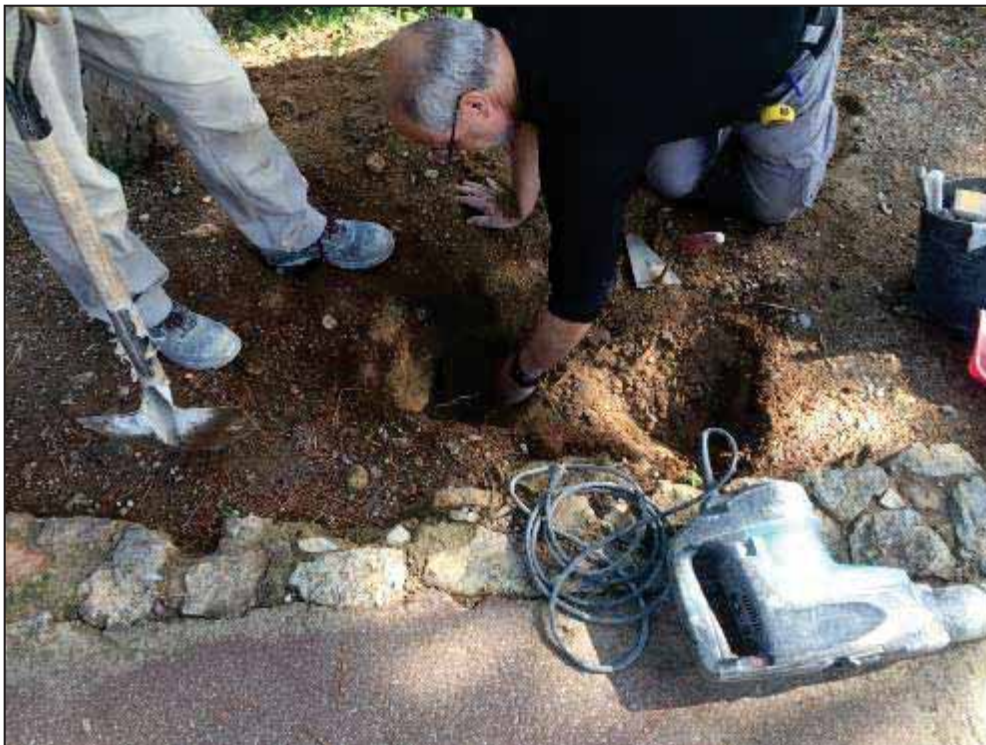
6. Operaris excavant forats arran d'un camí. (Itinerari D)
