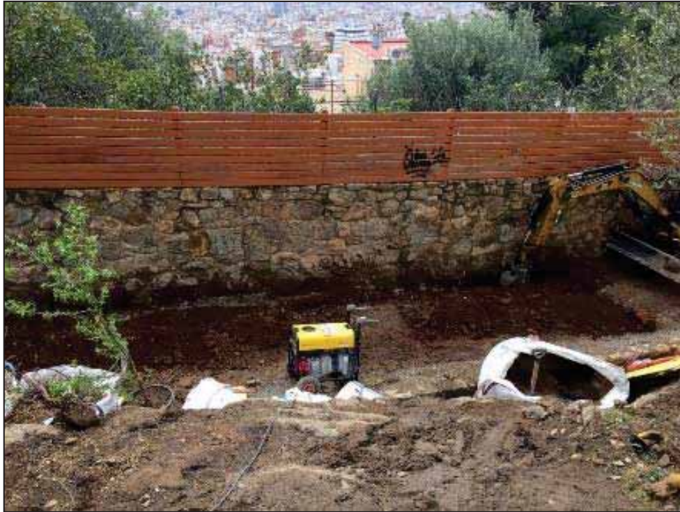
47. Realització d'una rasa UE1027 al camí ja existent per a passar serveis
