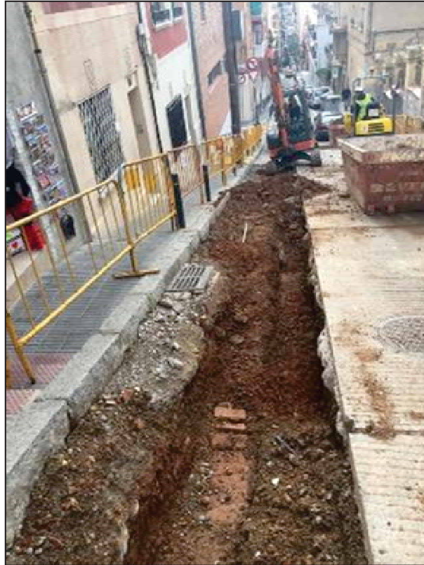
63. Desviament de la rasa per no passar per sobre del tub.
