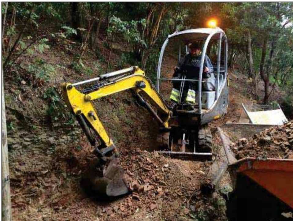
16. Màquina excavadora rebaixant terreny vegetal.
