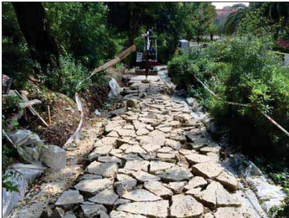
11. Maquina de petit tonatge picant el paviment de terra
