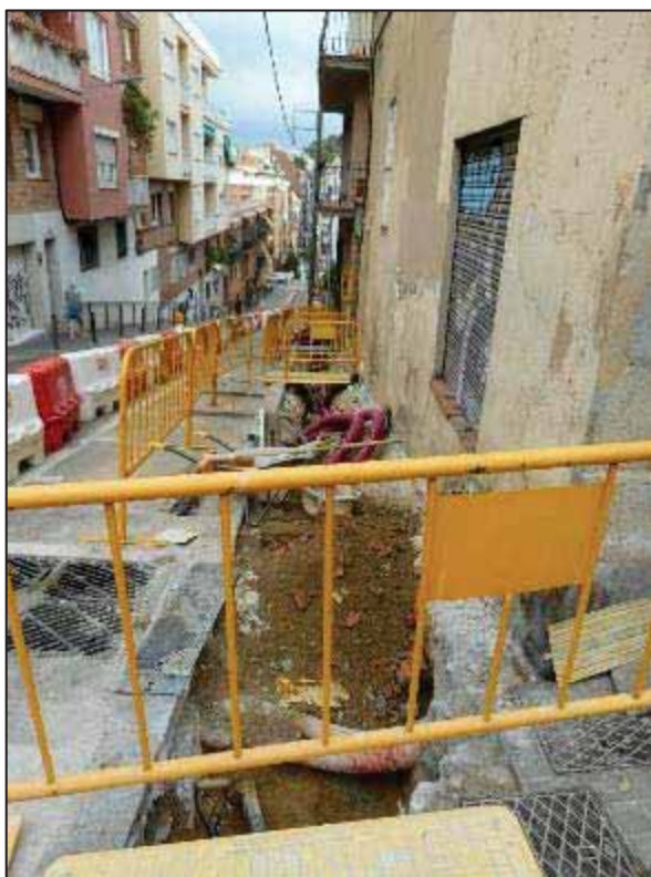
1. Treballs d'obertura en rasa a la Baixada de la Glòria, entre el carrer del Repartidor i passatge d'Espíria, anteriors al control.
