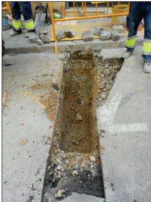
40. Tram de rasa al creuament del carrer de Sostres.
