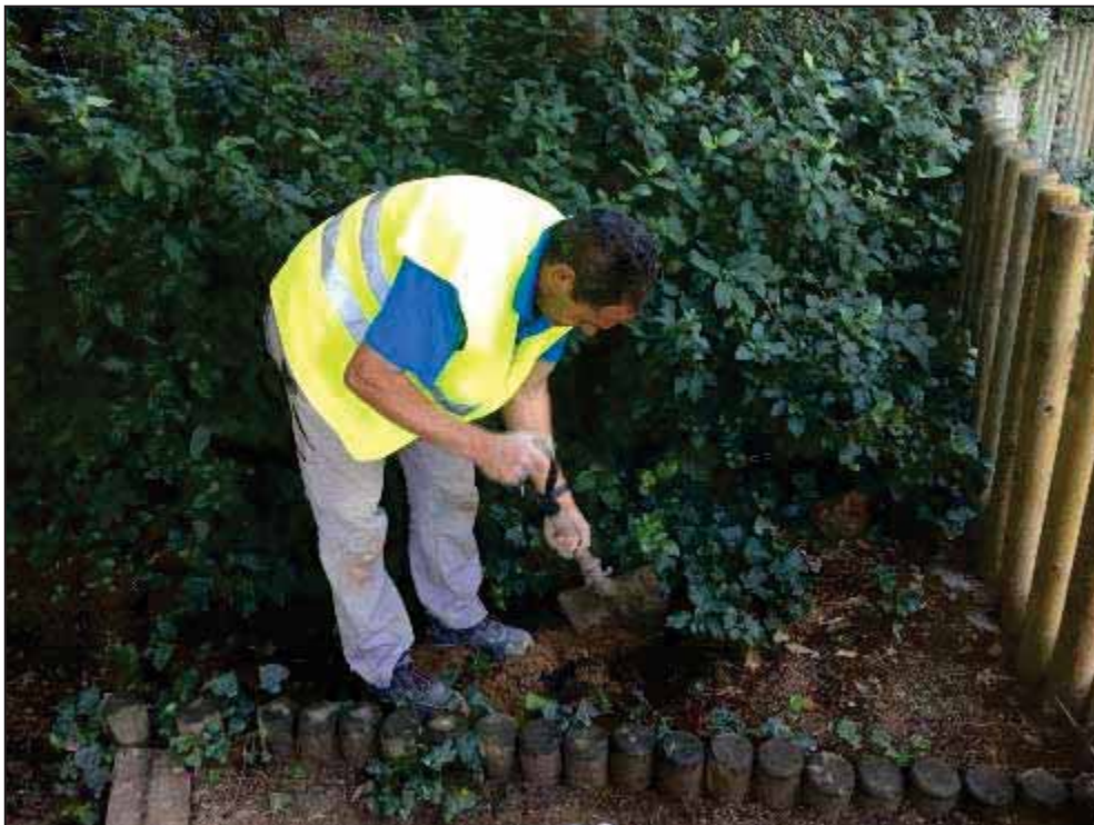
4. Foto 4: Operari excavant un forat en una jardinera. (Itinerari C)
