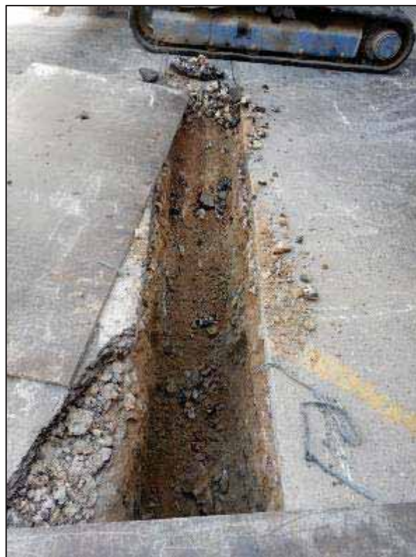
42. Tram de rasa al creuament del carrer de Sostres.
