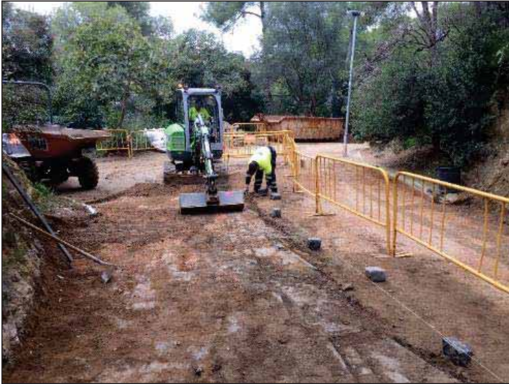
17. Màquina rebaixant terreny al Forat del Vent per la part de fora del parc.
