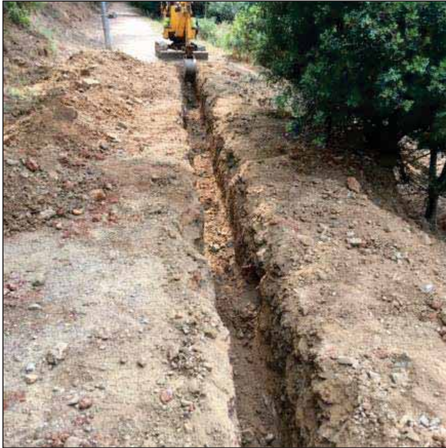
9. Tram de la rasa realitzada .
