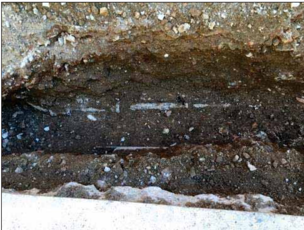
61. Tram on han aparegut els dos serveis trobats. El superior, un tub d'aigua en desús, l'inferior un cable elèctric encara en ús.
