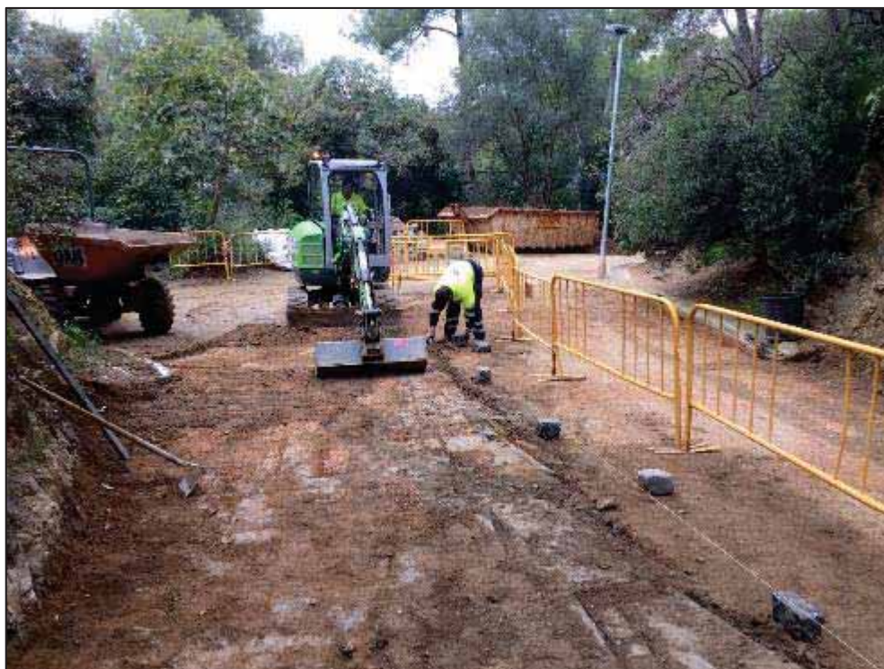
8. Màquina rebaixant terreny al Forat del Vent per la part de fora del parc.
