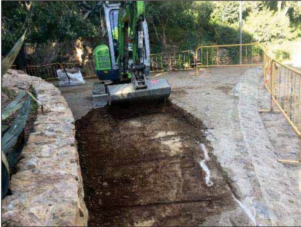
10. Màquina rebaixant terreny a l'entrada del Forat del Vent.
