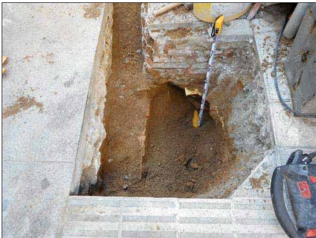
31. Tram de rasa al carrer de Verdi i arqueta.
