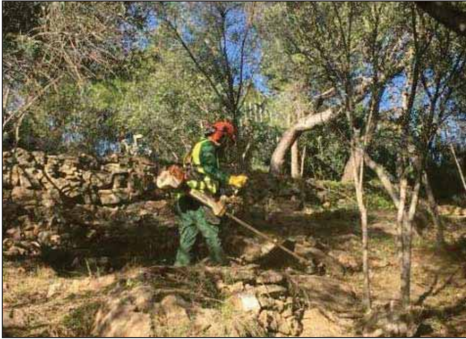
3. Desbrossament de la zona amb màquina desbrossadora.
