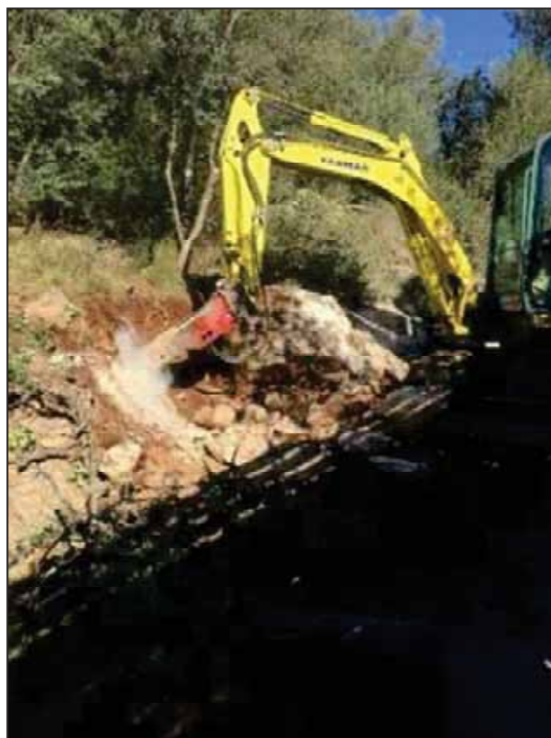
8. Màquina giratòria de poc tonatge picant la roca natural
