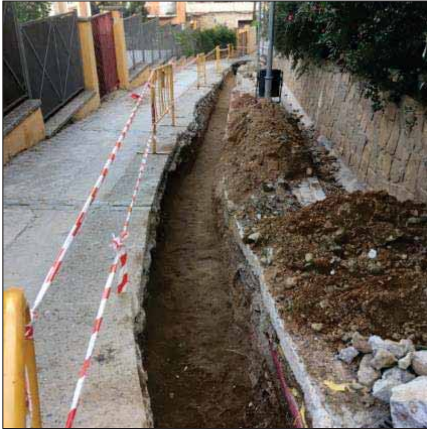
13. Rasa realitzada al camí d'accés al Park Güell des del carrer del Torrent del Remei. Presència de diferents seveis que travessen
