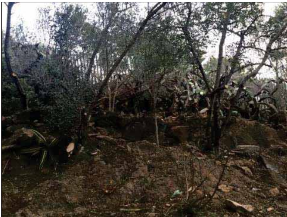
14. Murs de contenció de terres.
