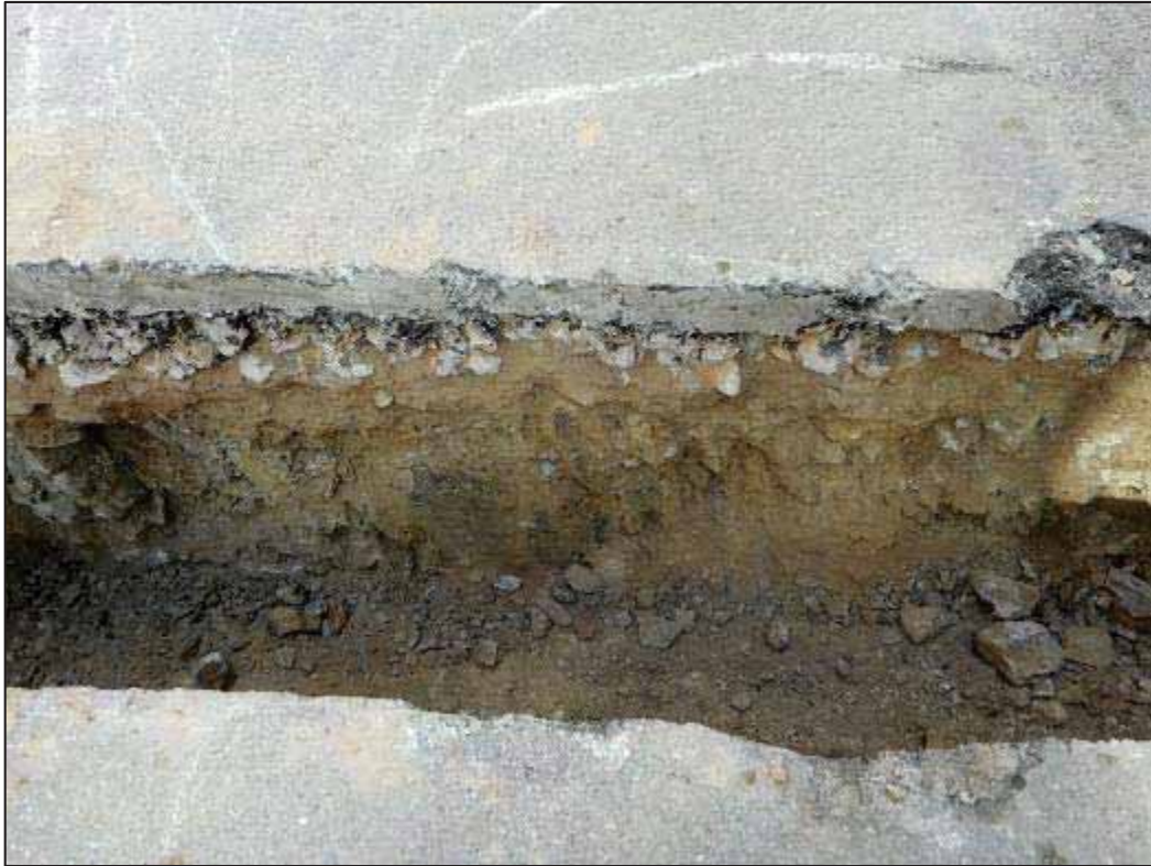
45. Perfil estratigràfic a la zona del creuament en calçada del carrer de Sostres.
