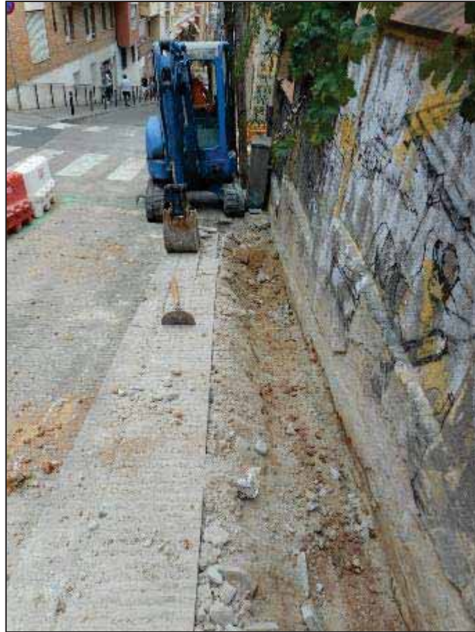
27. Tram de rasa entre el carrer del Repartidor i el carrer de Verdi.
