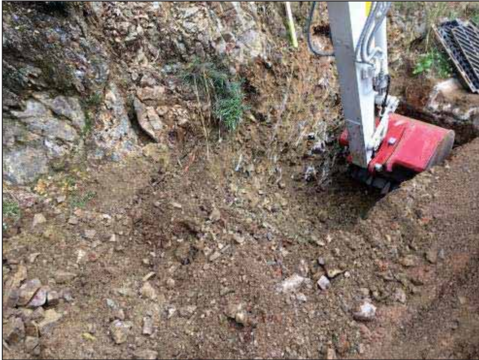
34. Màquina excavant la rasa.
