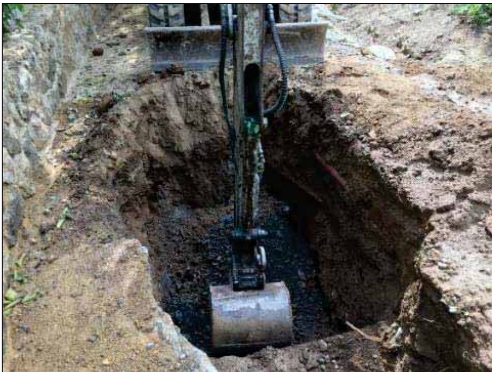
17. Realització d'un pou per a la construcció d'una arqueta.
