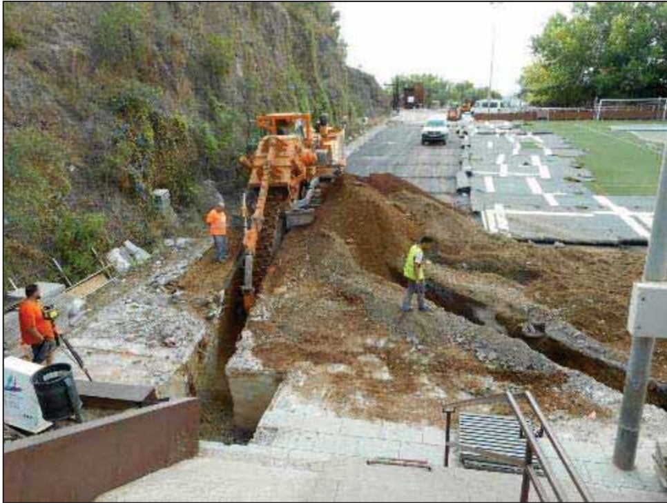
11. Màquina realitzant el tram de rasa al Nord del camp de futbol.
