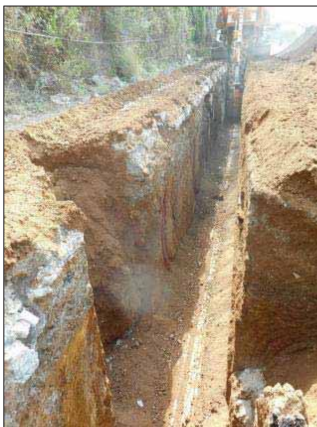
16. Màquina realitzant el tram de rasa al Nord del camp de futbol.
