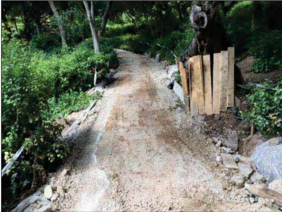
12. Paviment de terra extret i preparat per a realitzar la rasa central i els pous per a les arquetes
