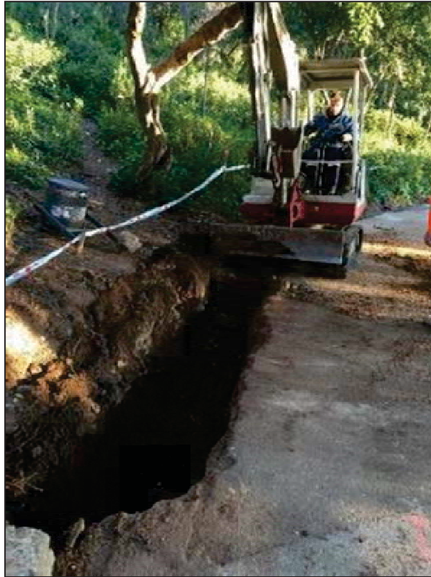
2. Màquina de petit tonatge realitzant la rasa oest
