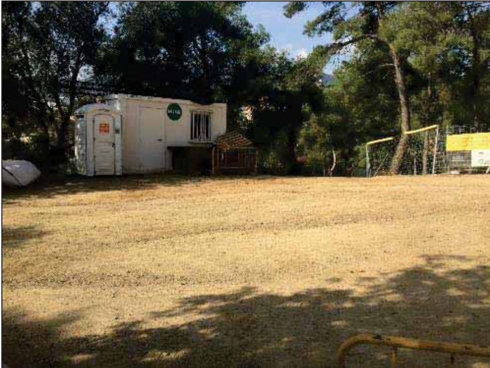
30. Zona on es realitza la rasa nord.
