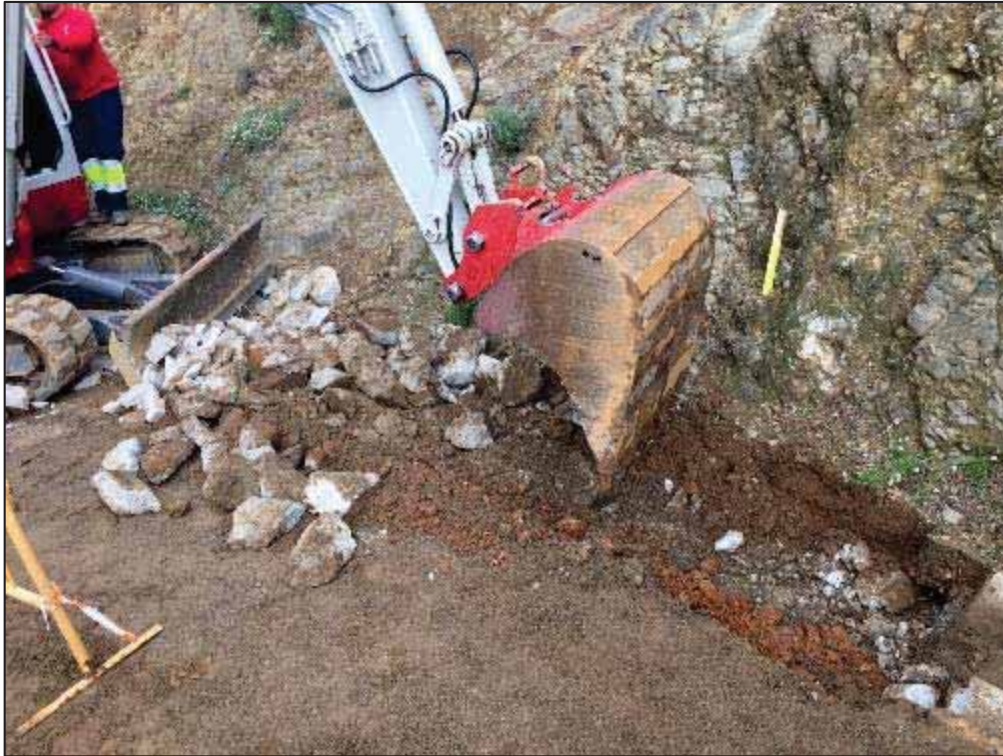
32. Màquina començant a fer la rasa.
