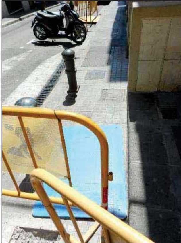
35. Treballs d'obertura en rasa al carrer de Sostres.
