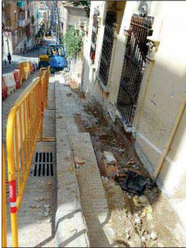
25. Tram de rasa entre el carrer del Repartidor i el carrer de Verdi.
