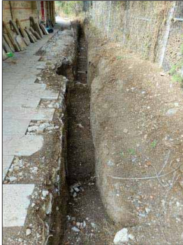
7. Tram de rasa per sobre les graderies del camp de futbol.
