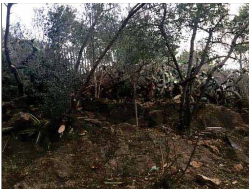
30. Mur de contenció UE 1009.
