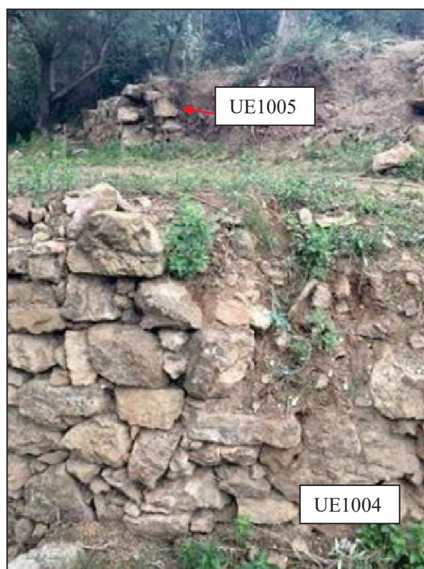
26. Murs de contenció UE 1004 i 1005.
