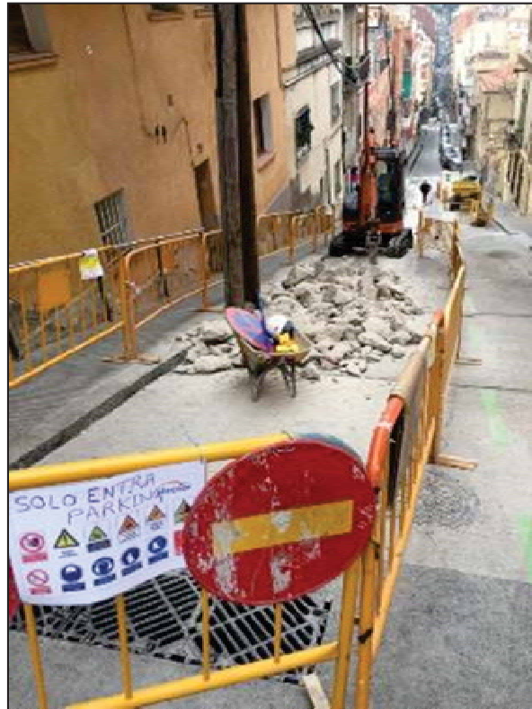
51. Màquina giratòria de petit tonatge picant el ciment del carrer.
