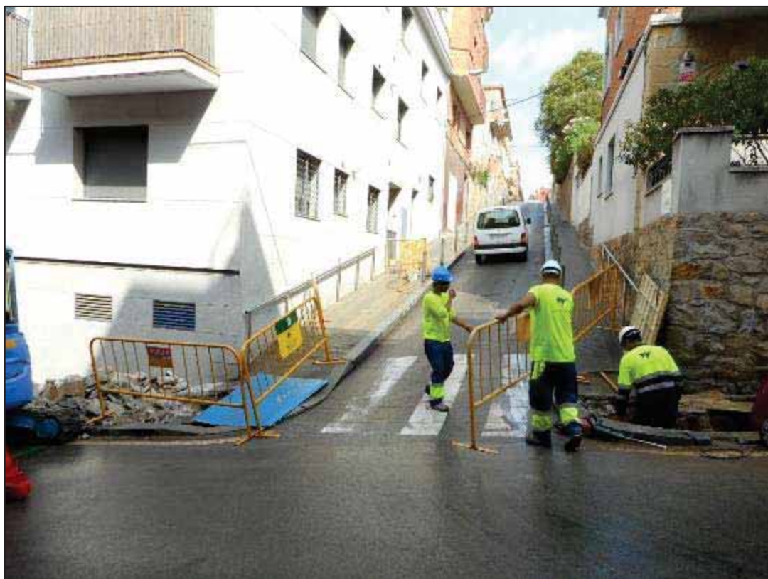
5. Treballs d'obertura en rasa del creuament al passatge d'Espíria.
