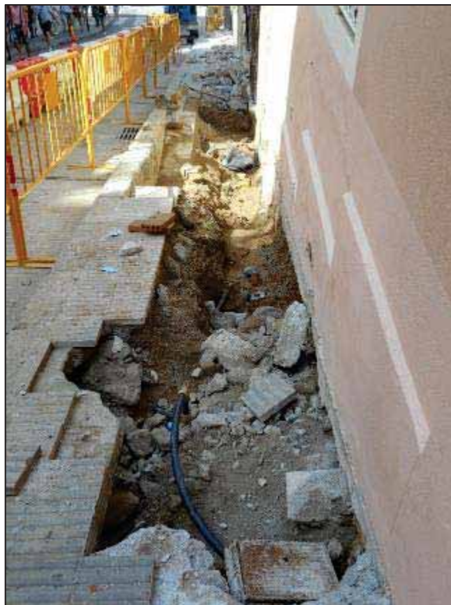
24. Tram de rasa a la cantonada del carrer de Verdi i la Baixada de la Glòria 39A.
