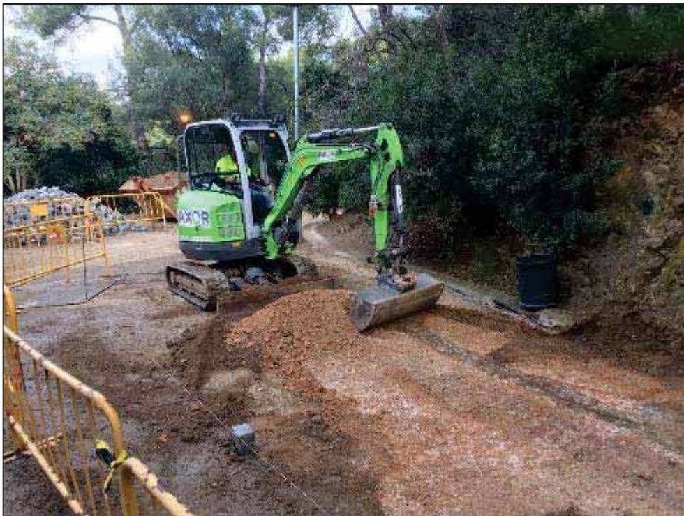
7. Màquina rebaixant terreny del Forat del Vent.
