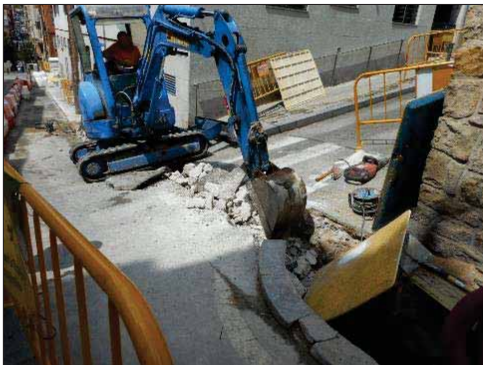
7. Treballs d'obertura en rasa del creuament al passatge d'Espíria.
