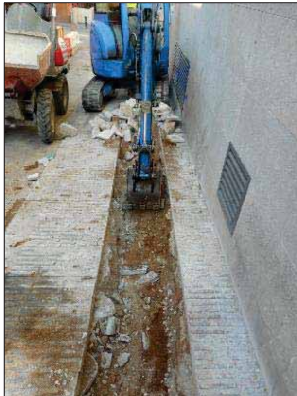
10. Treballs d'obertura en rasa a la Baixada de la Glòria, entre el passatge d'Espíria i el carrer de la Mare de Déu del Coll.
