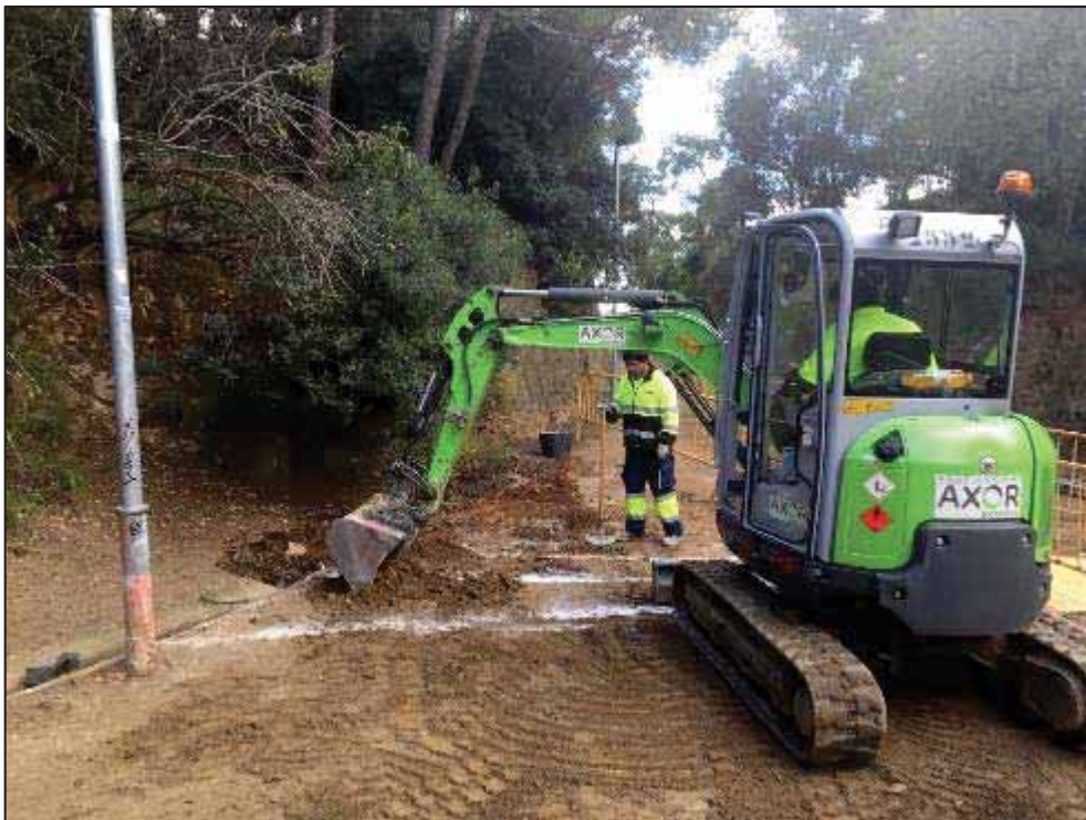
17. Màquina realitzant la rasa que ha de connectar les canalitzacions d'ambdós costats.
