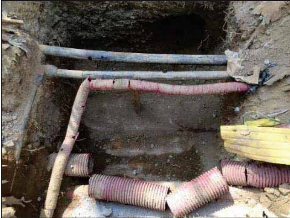
20. Zona de connexió del tub del camí de la Pressió amb el tub del passeig de les Palmeres.
