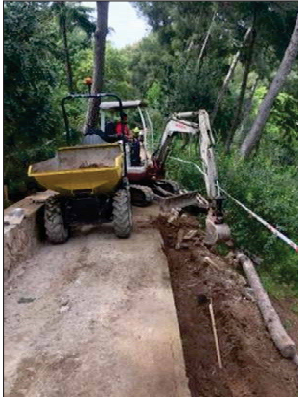
6. Maquina de petit tonatge realitzant la rasa est al principi del camí (segona rasa)
