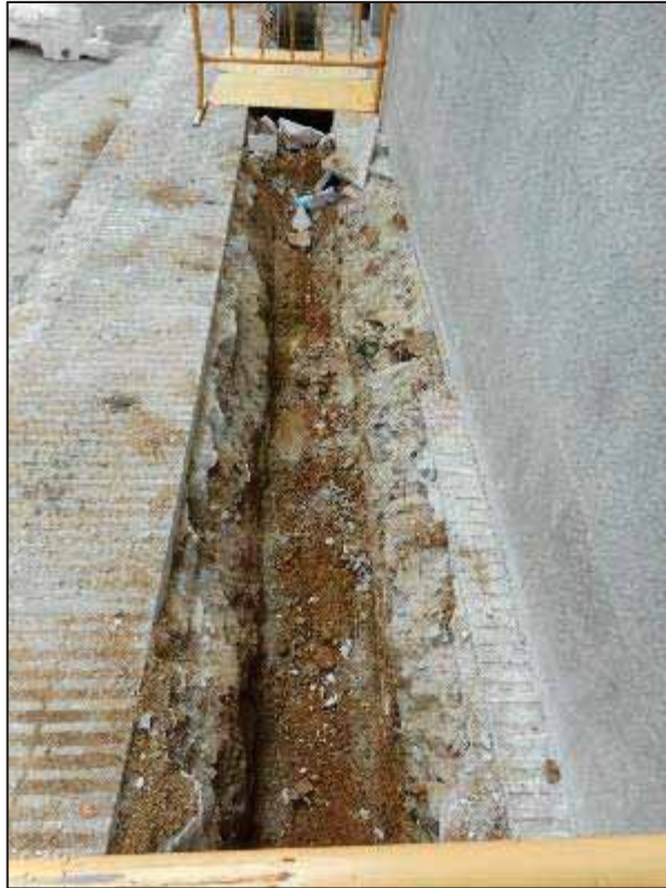
13. Treballs d'obertura en rasa a la Baixada de la Glòria, entre el passatge d'Espíria i el carrer de la Mare de Déu del Coll.
