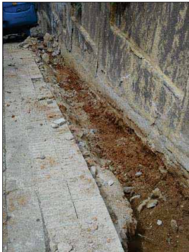
26. Tram de rasa entre el carrer del Repartidor i el carrer de Verdi.
