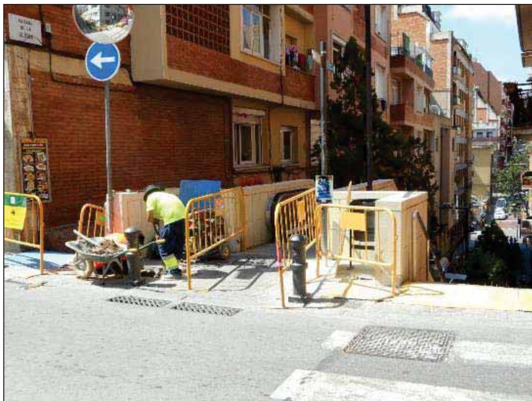
32. Treballs d'obertura en rasa al carrer de Sostres.
