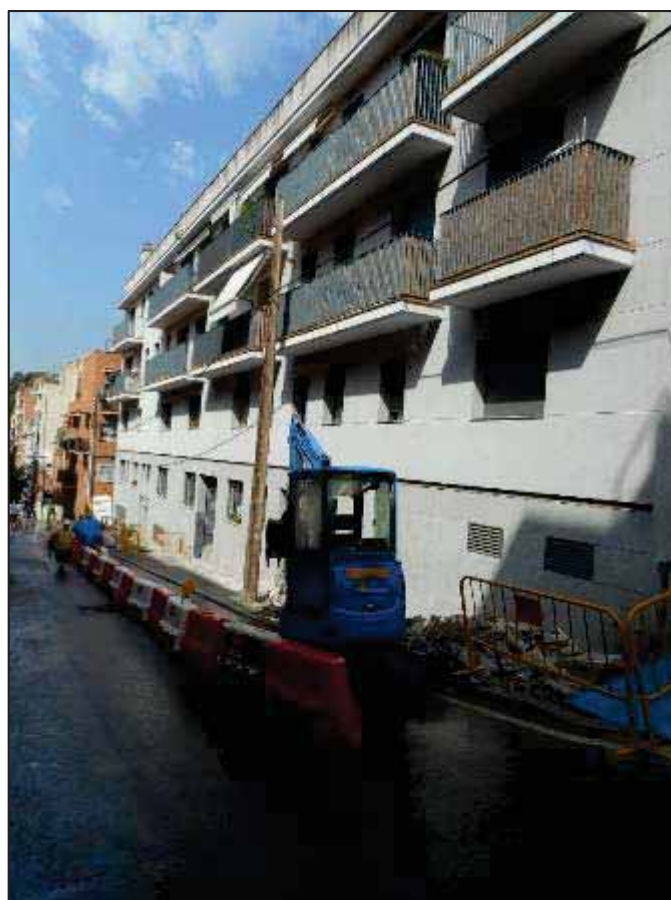
8. Treballs d'obertura en rasa a la Baixada de la Glòria, entre el passatge d'Espíria i el carrer de la Mare de Déu del Coll.
