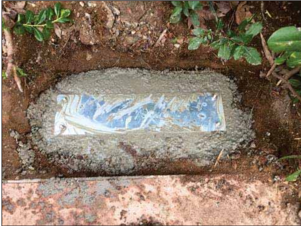
11. Fonamentació de la senyalització acabada. (Itinerari A)
