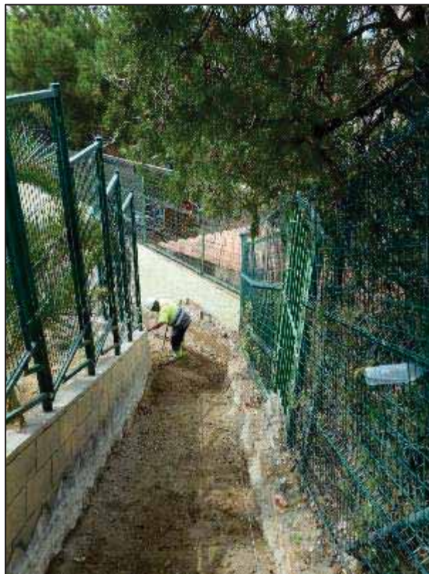
2. Treballs finals d'anivellament de terres a les escales Pompeu Fabra, previs al control arqueològic.
