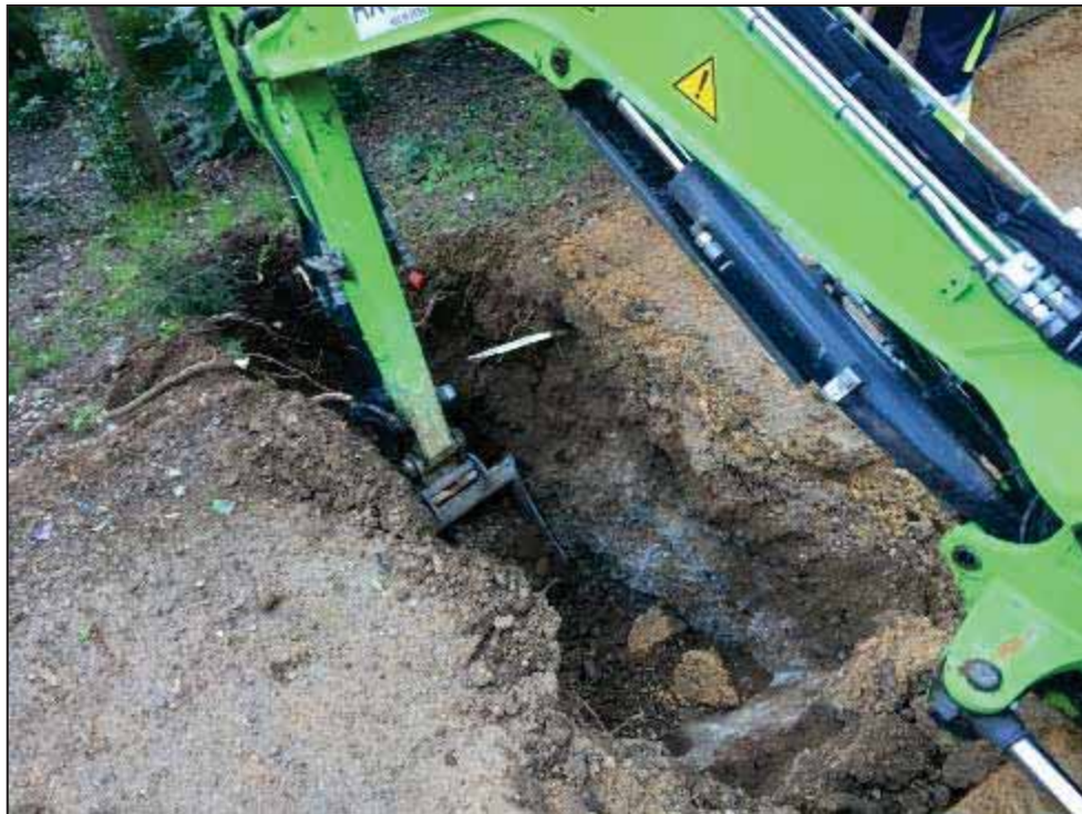
27. Màquina realitzant la rasa sud.
