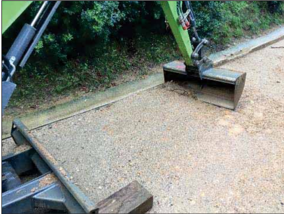
20. Màquina començant a rebaixar el terreny.
