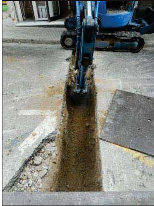
43. Obertura en rasa en calçada al carrer de Sostres.
