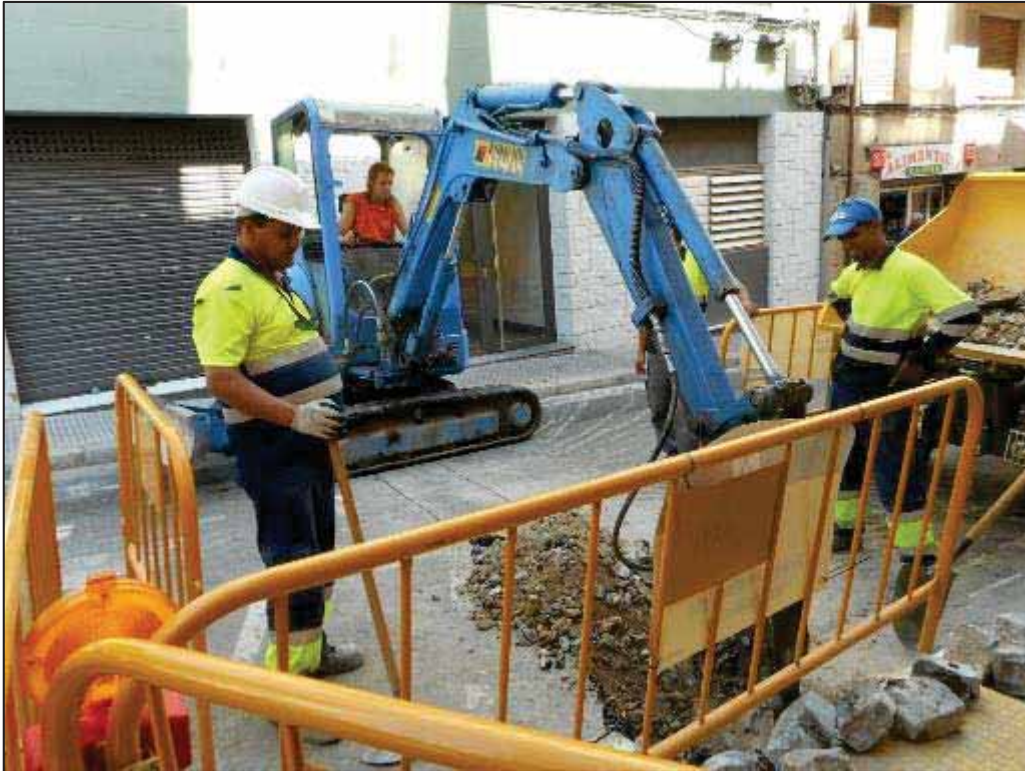
39. Obertura en rasa en calçada al carrer de Sostres.
