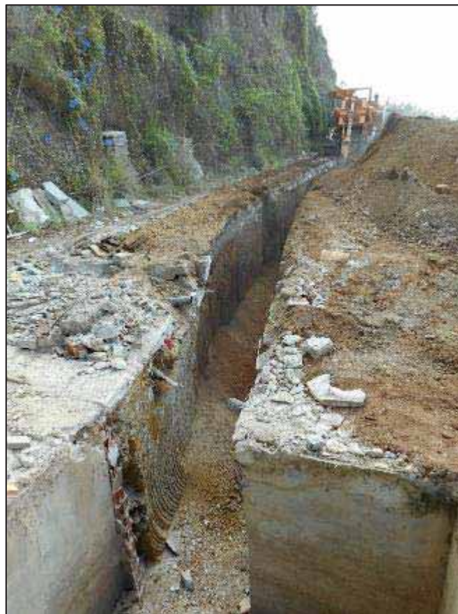
14. Màquina realitzant el tram de rasa al Nord del camp de futbol.
