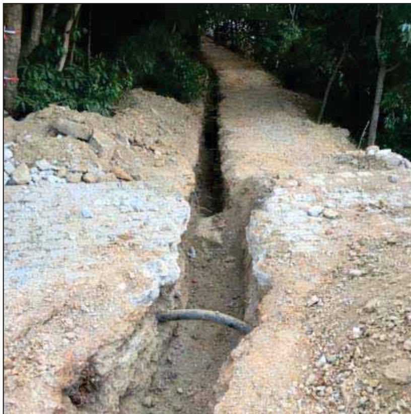
6. Rasa on apareix l'estructura UE 2003
