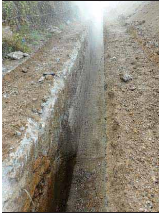
19. Tall estratigràfic del tram nord de la rasa del camp de futbol, s'aprecia el paviment de formigó, la capa d'anivellament i seguidament el terreny geològic.
