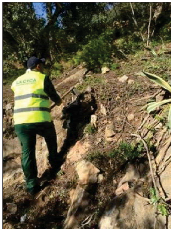
4. Arrencament de soques amb xapo.
