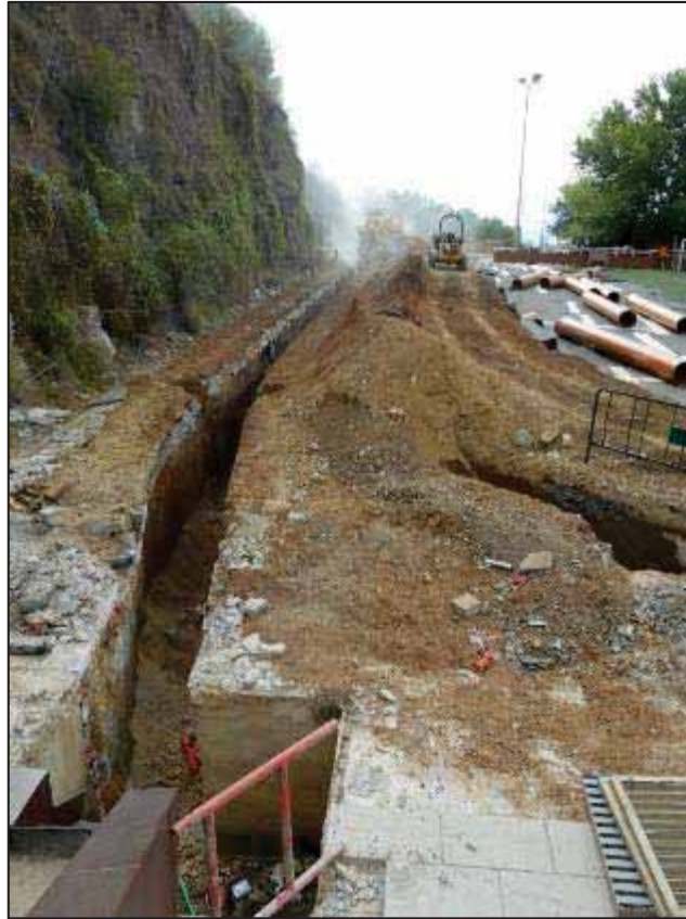
23. Vista general del tram Nord de la rasa del camp de futbol.
