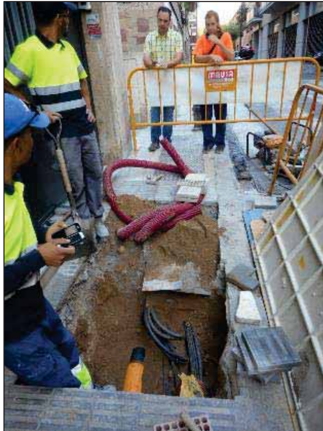
38. Treballs d'obertura en rasa al carrer de Sostres.
