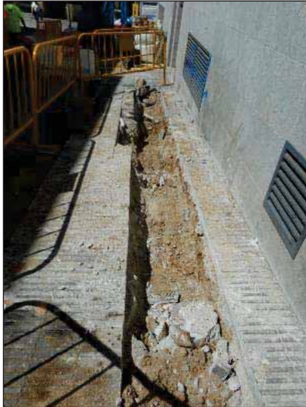
11. Treballs d'obertura en rasa a la Baixada de la Glòria, entre el passatge d'Espíria i el carrer de la Mare de Déu del Coll.
