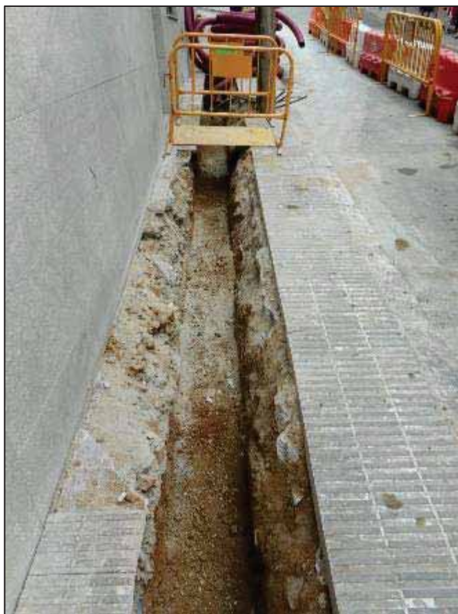
17. Treballs d'obertura en rasa a la Baixada de la Glòria, entre el passatge d'Espíria i el carrer de la Mare de Déu del Coll.
