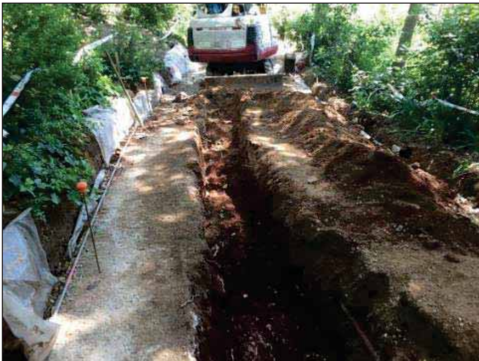
13. Realització de la rasa central.
