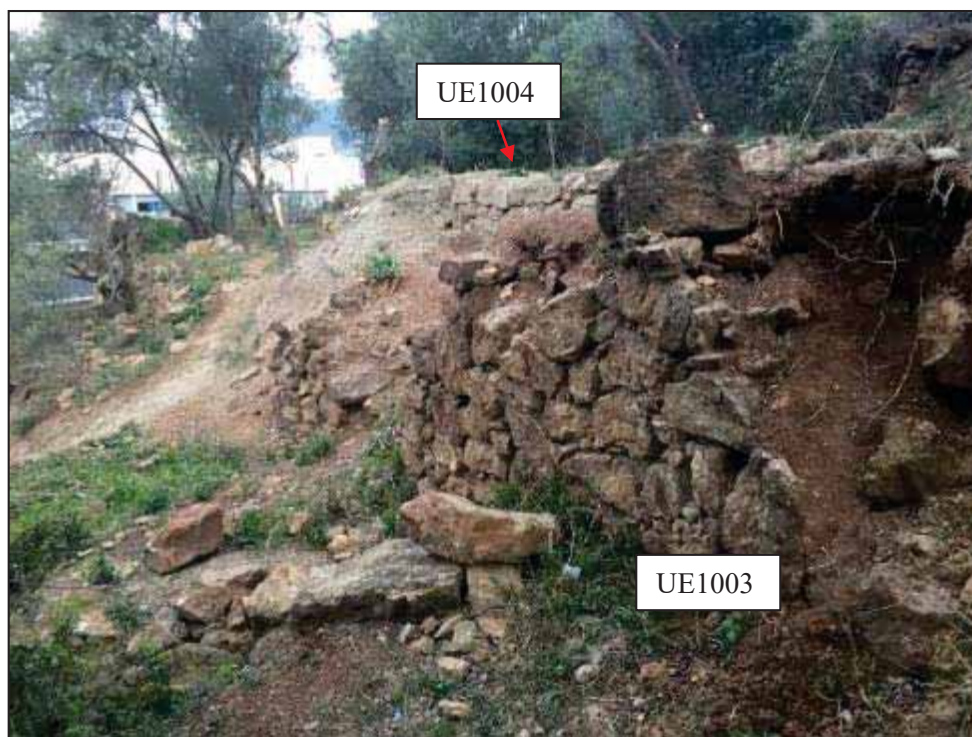
24. Murs de contenció. Al davant el mur UE 1003 i darrera el mur UE1004.
