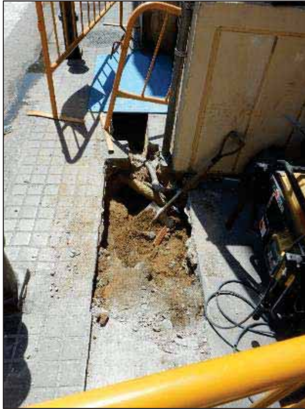
33. Treballs d'obertura en rasa al carrer de Sostres.
