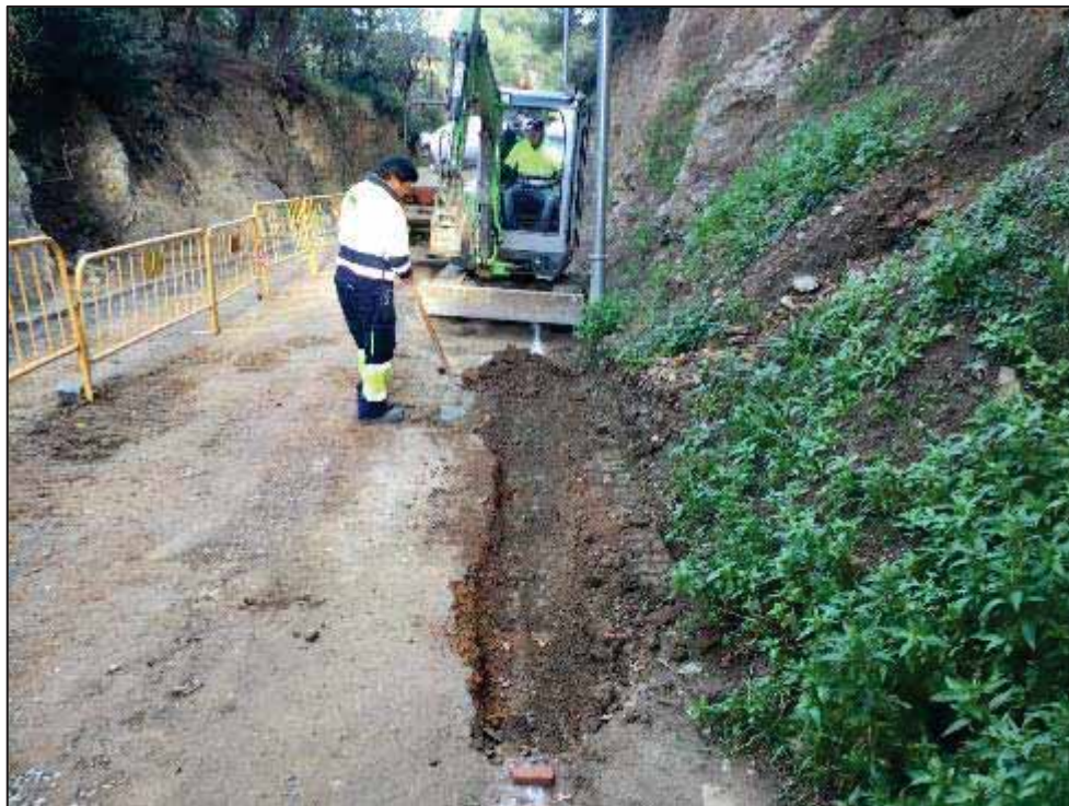
13. Màquina realitzant la rasa nord del Forat del Vent.
