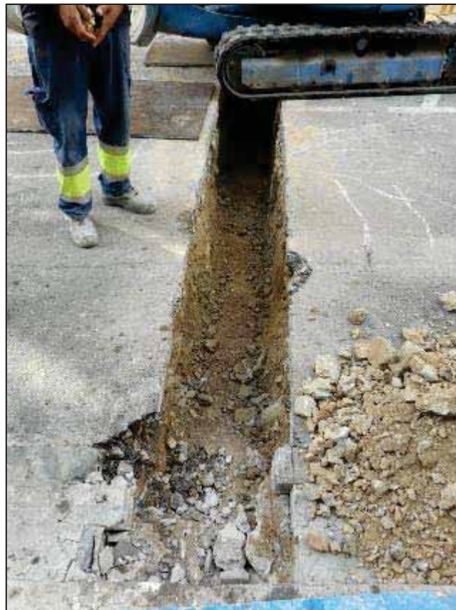
44. Tram de rasa al carrer de Sostres finalitzat.
