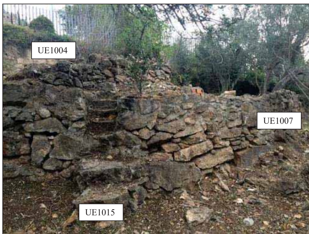
29. Murs de contenció UE1004 i 1007 i escala UE 1015.
