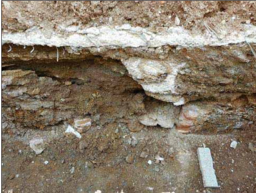
13. Secció del terreny de la rasa nord, restes de conduccions contemporànies obrades amb maons, material de runa.
