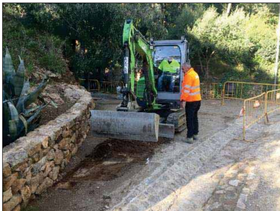
9. Màquina rebaixant terreny a l'entrada del Forat del Vent.
