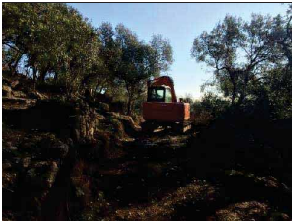
23. Camí passant entre els murs UE 1003 i UE 1004.
