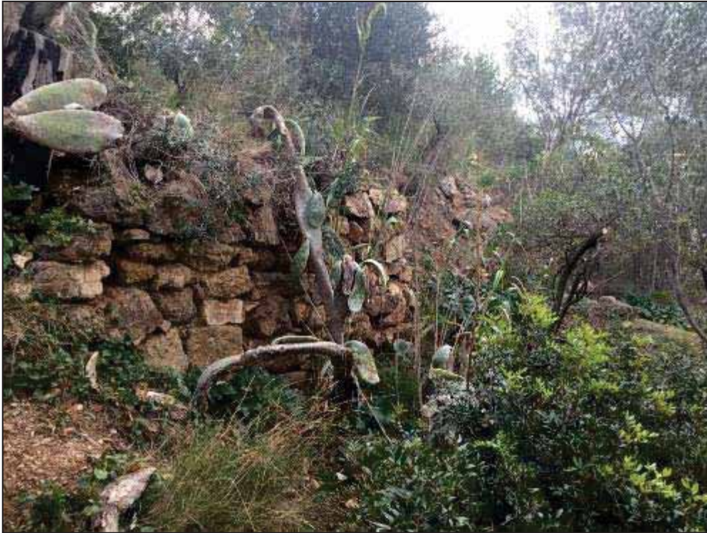
27. Mur de contenció UE 1005.
