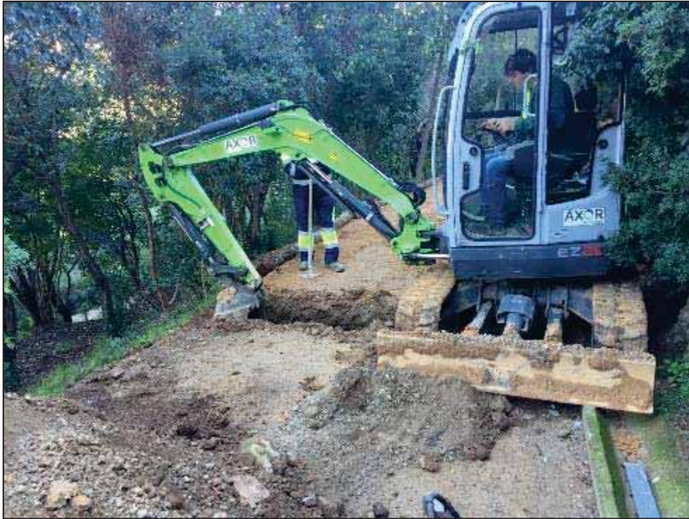
26. Màquina realitzant la rasa sud.
