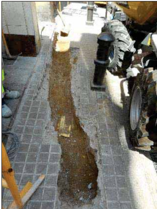
36. Treballs d'obertura en rasa al carrer de Sostres.
