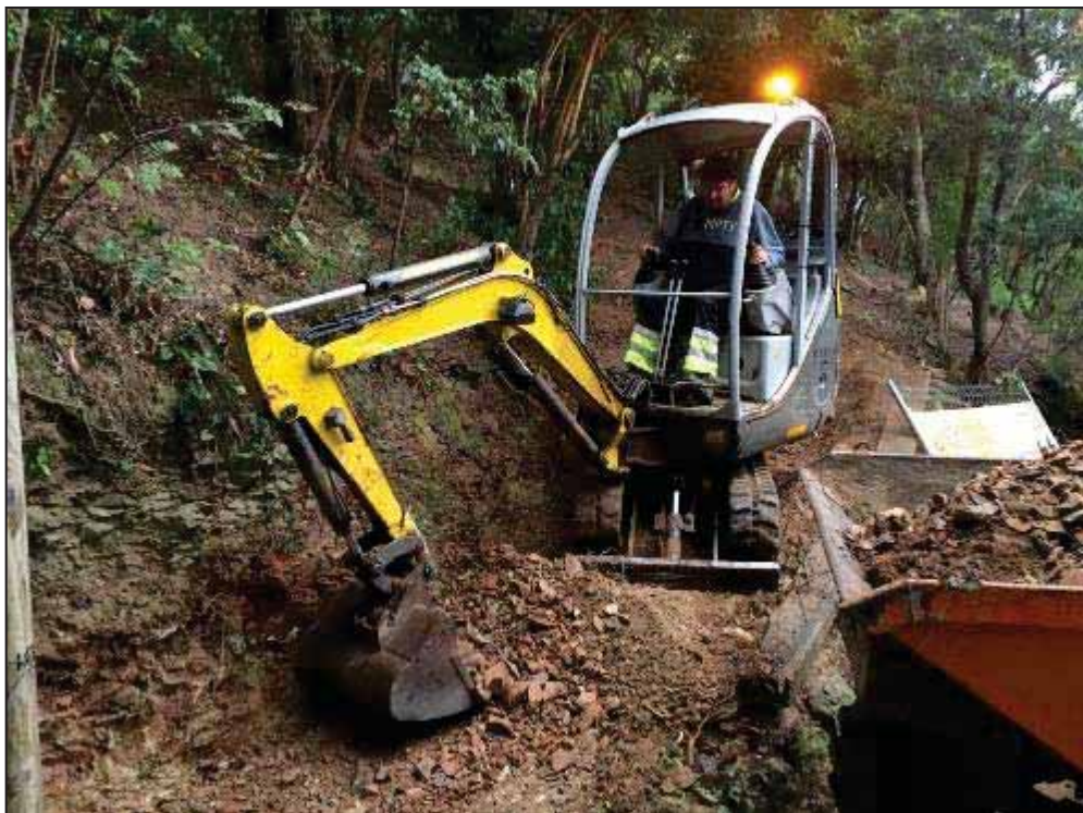
3. Màquina excavadora rebaixant terreny vegetal.
