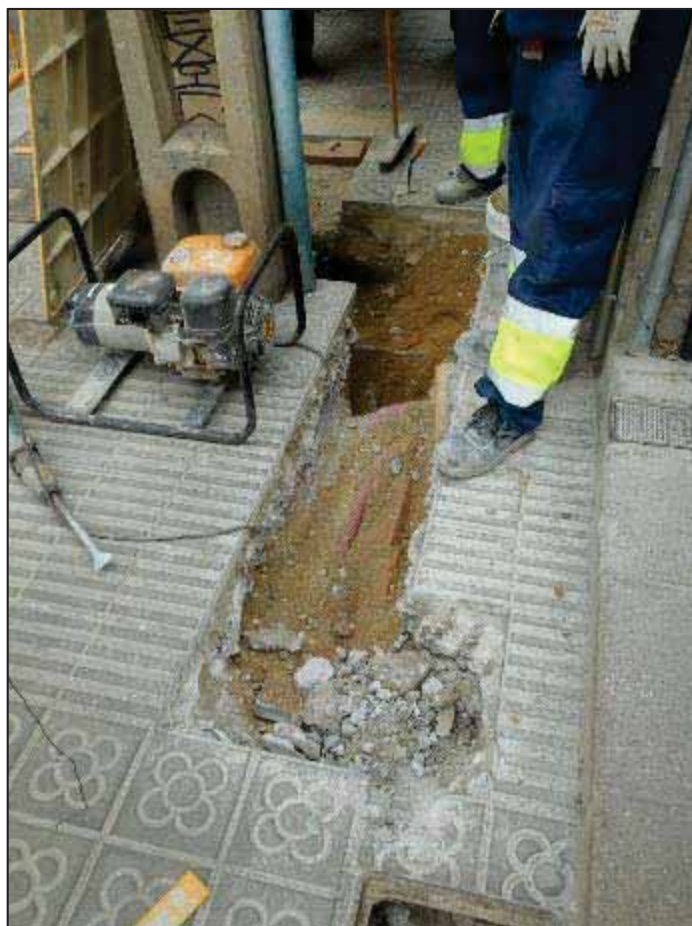
29. Treballs de soterrament de línia telefònica a la cantonada nord-oest del carrer de Verdi.
