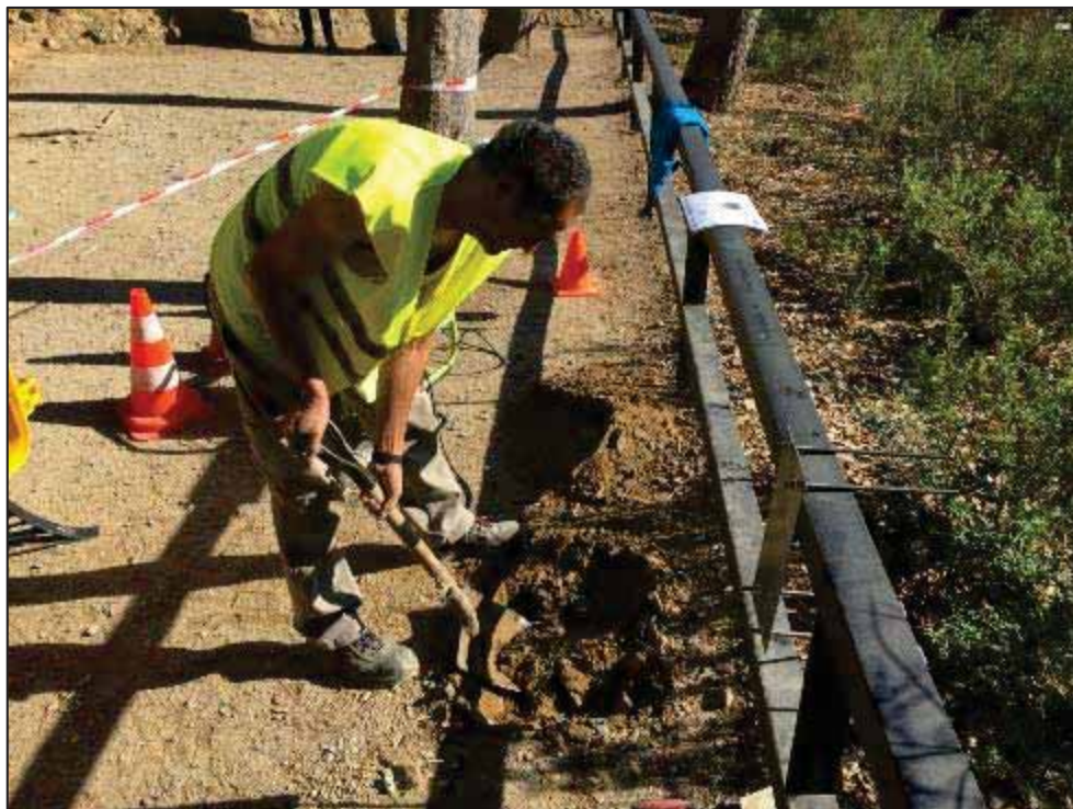
2. Operari excavant un forat en “paviment” de terra premsada. (Itinerari B)
