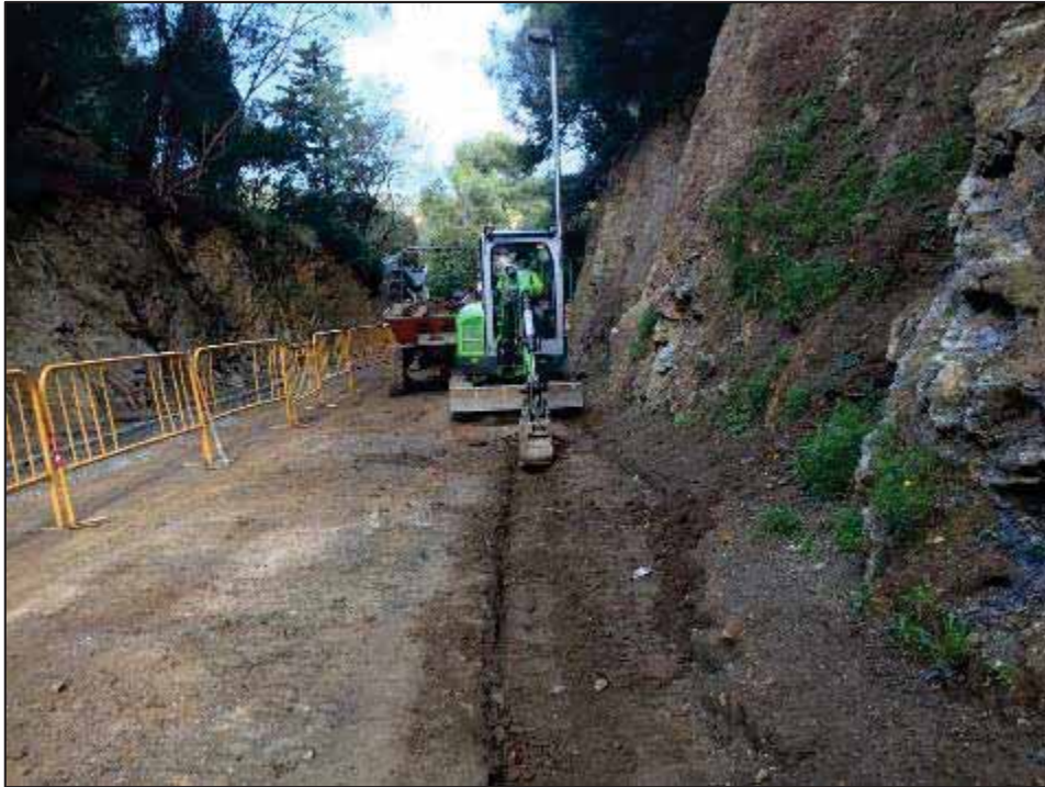
14. Màquina realitzant la rasa nord del Forat del Vent.
