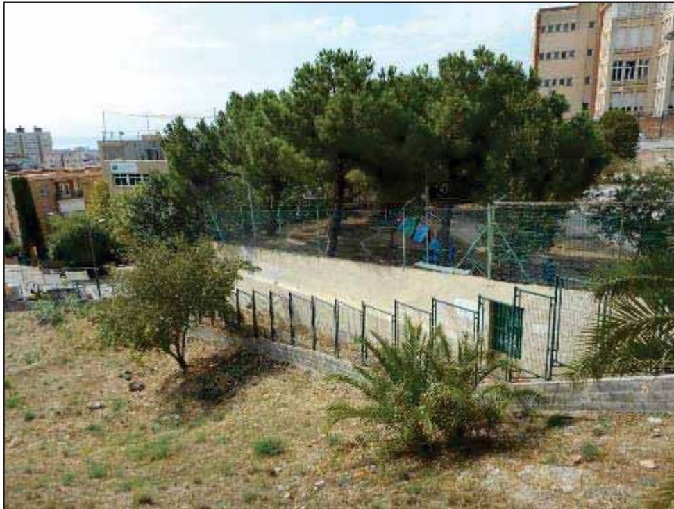
1. Vista general del Lot1: Escales Pompeu Fabra.
