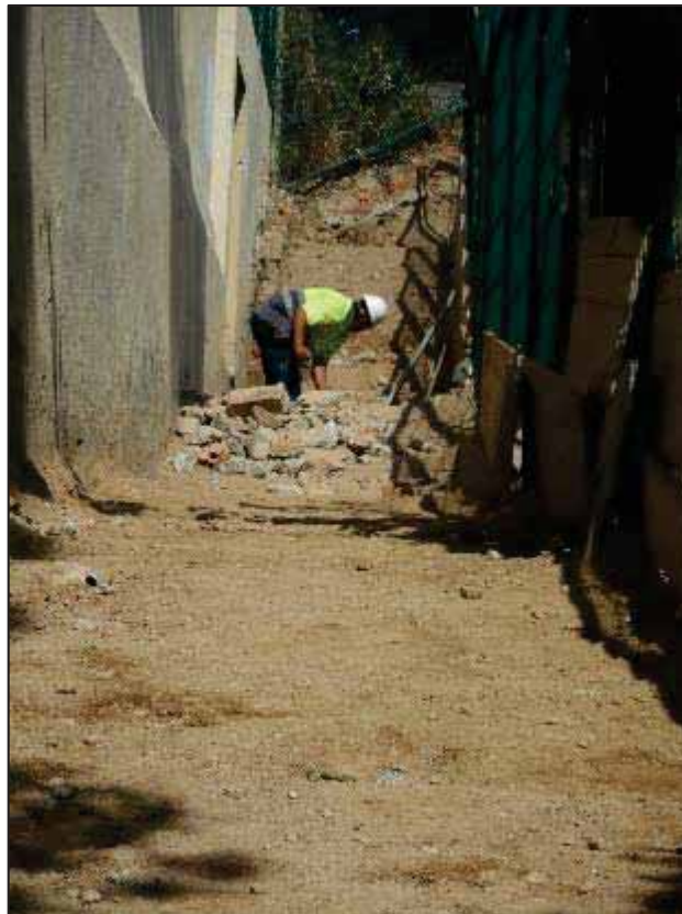
4. Operaris realitzant l'anivellament del terreny.
