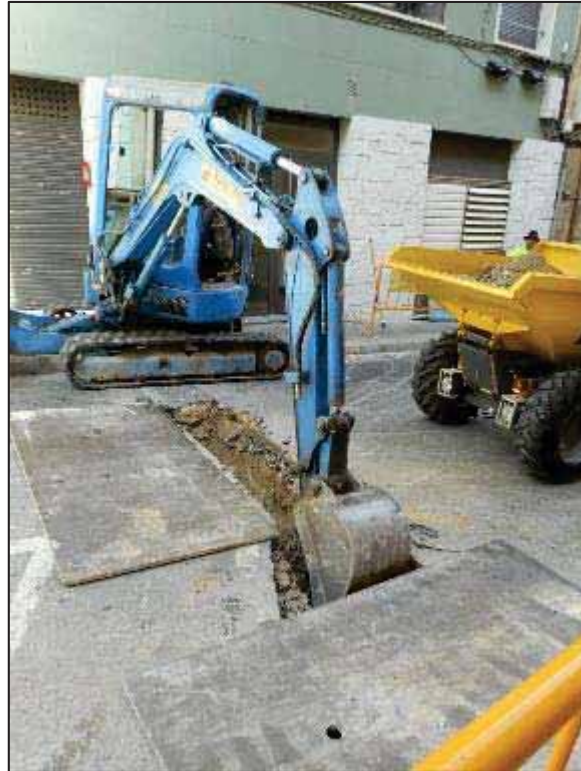
41. Obertura en rasa en calçada al carrer de Sostres.
