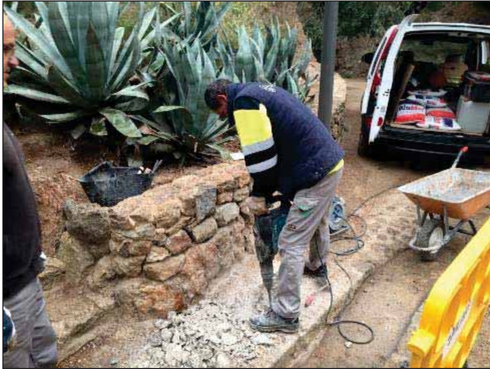
7. Operari picant pedra per tal de fer el forat. (Itinerari E)
