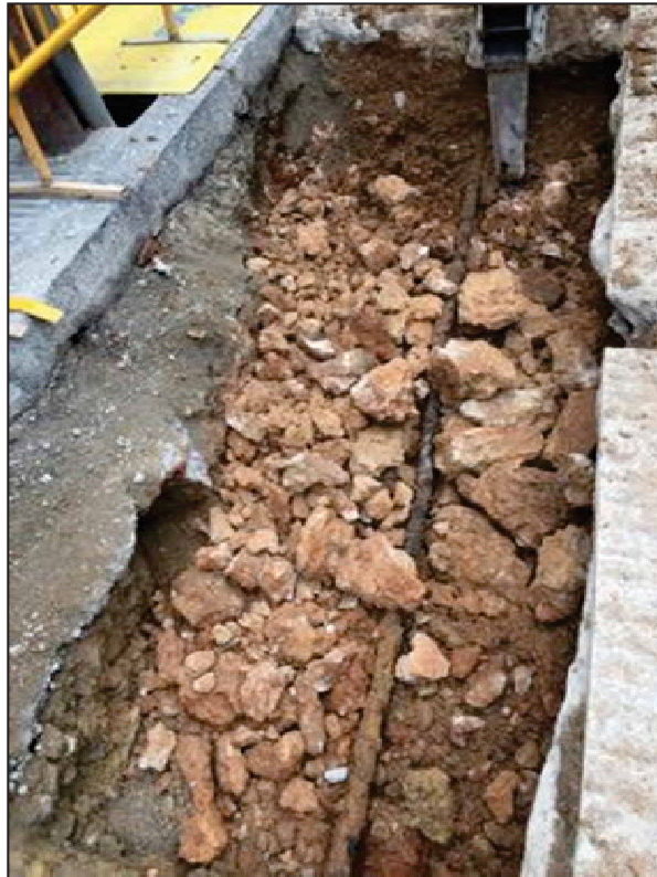
59. Tram final de la rasa, on s'ha hagut de picar la roca natural
