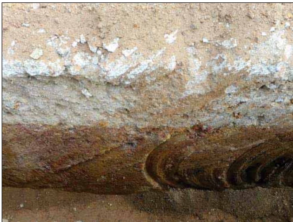
18. Tall estratigràfic del tram nord de la rasa del camp de futbol, s'aprecia el paviment de formigó, la capa d'anivellament i seguidament el terreny geològic.
