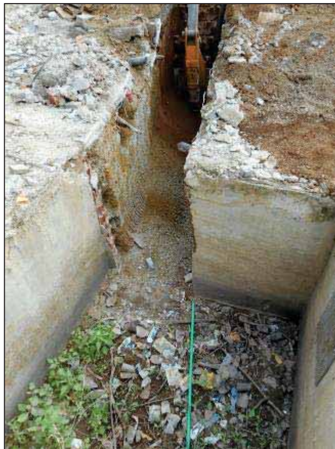
12. Detall de soterrani anterior als treballs, a l'inici de la rasa del nord del camp de futbol.
