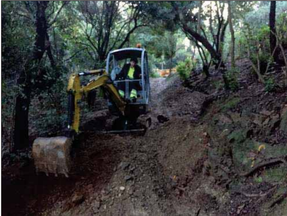
4. Màquina excavadora rebaixant terreny vegetal.
