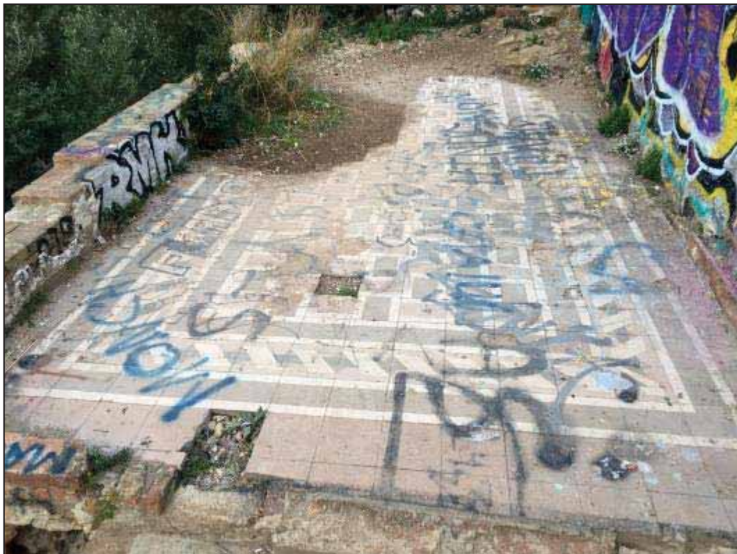
42. Paviment barraca UE 1023.
