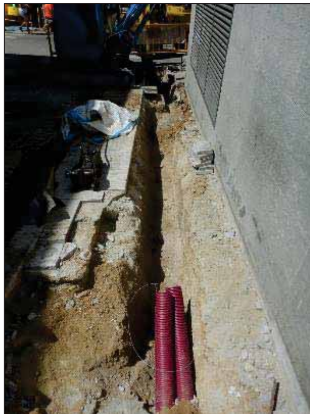
20. Treballs d'obertura en rasa a la Baixada de la Glòria, entre el passatge d'Espíria i el carrer de la Mare de Déu del Coll.
