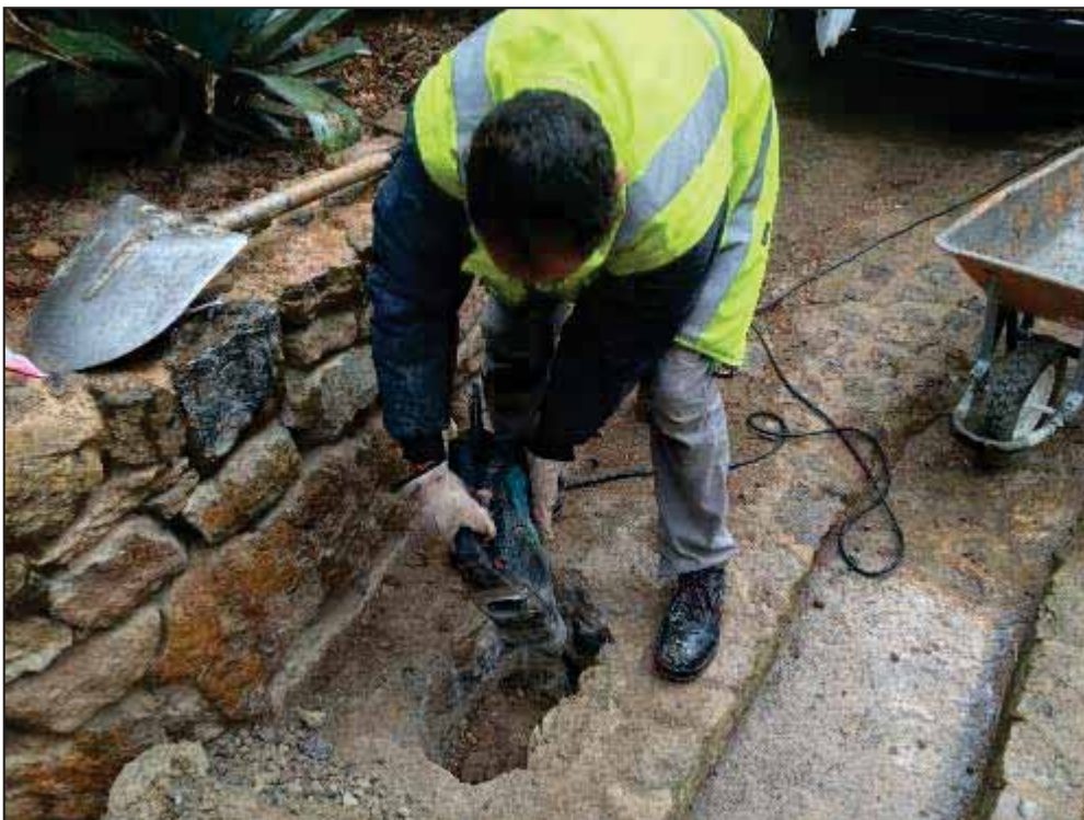
8. Operari picant pedra per tal de fer el forat. (Itinerari E)
