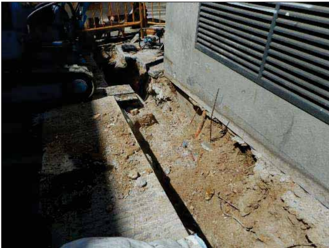
22. Treballs d'obertura en rasa a la Baixada de la Glòria, a la cantonada del carrer de la Mare de Déu del Coll.
