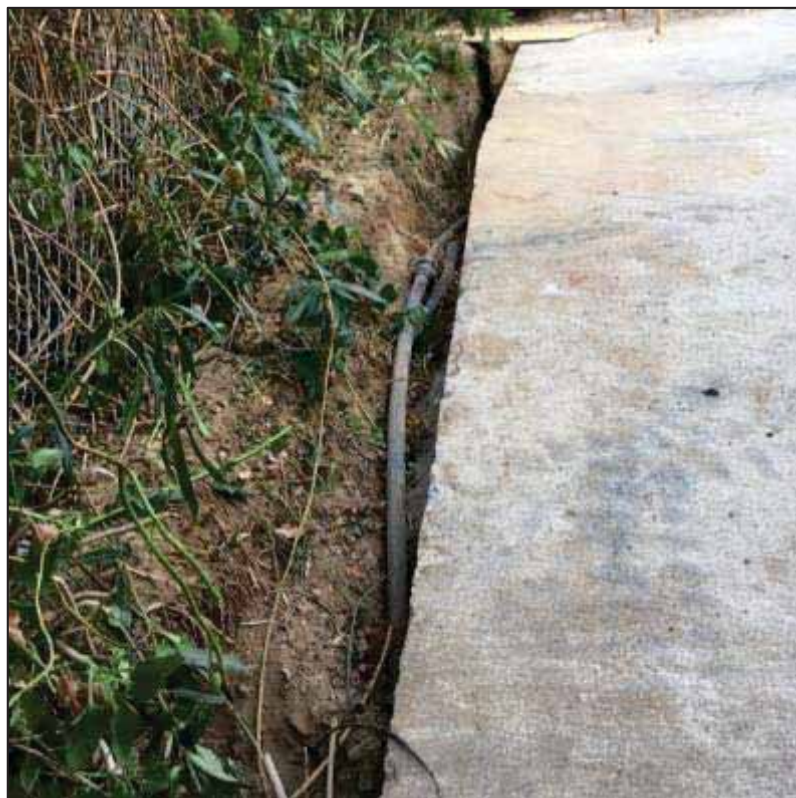
2. Rasa realitzada sense control arqueològic. Presència de diversos serveis d'aigua.
