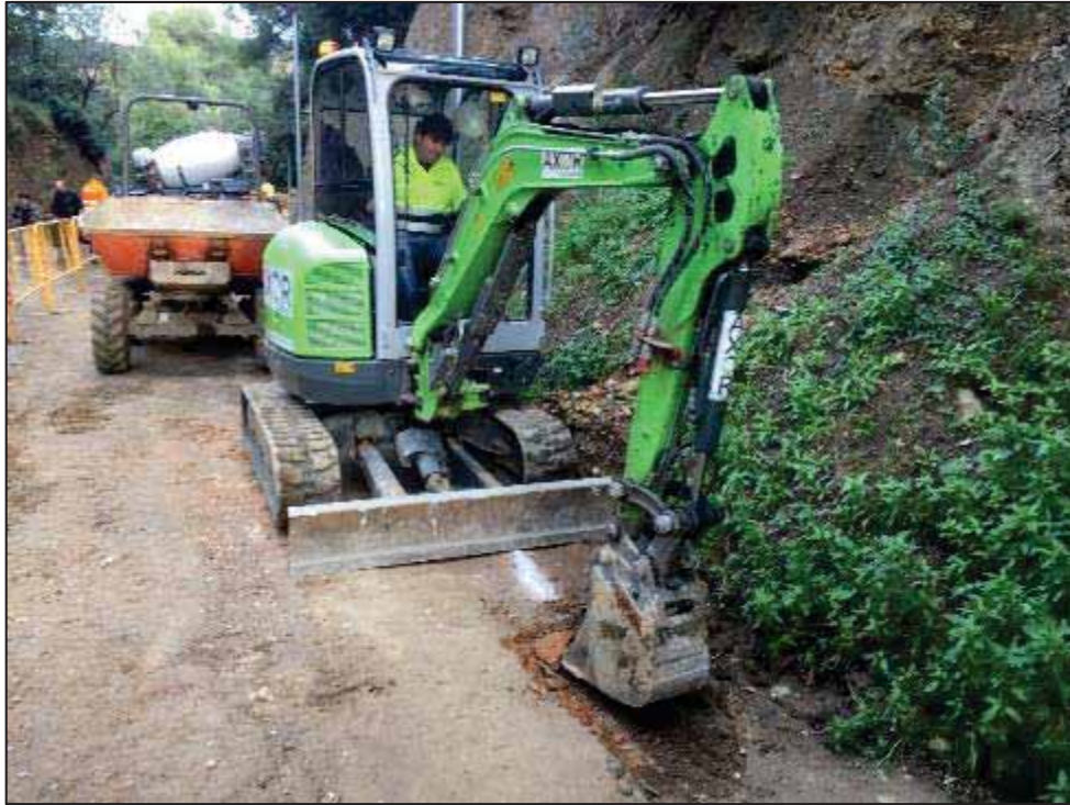
12. Màquina realitzant la rasa nord del Forat del Vent.
