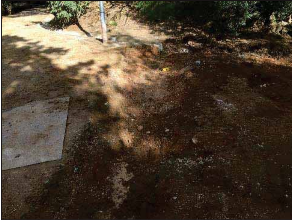
18. Rasa per construir la canalització que connectarà les canalitzacions laterals.
