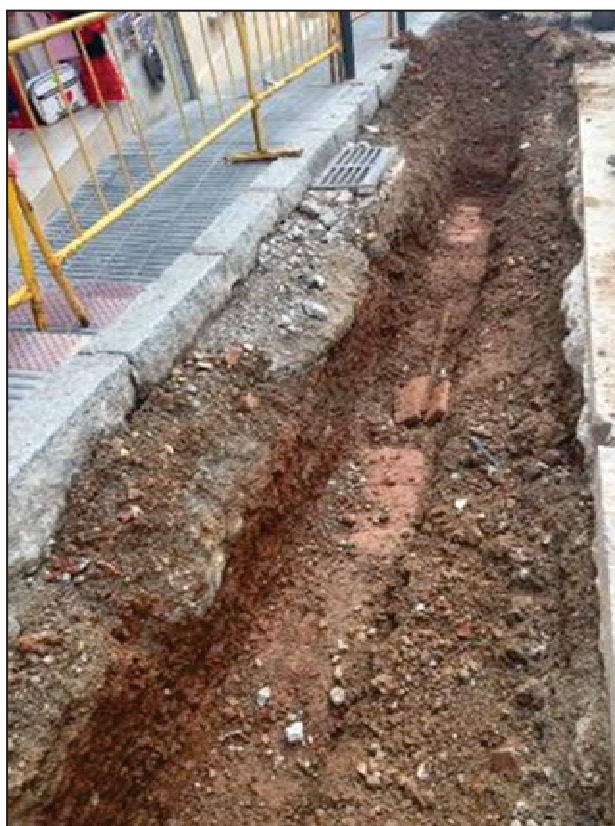
62. Protecció del cable elèctric. El tub d'aigua ja ha estat extret.
