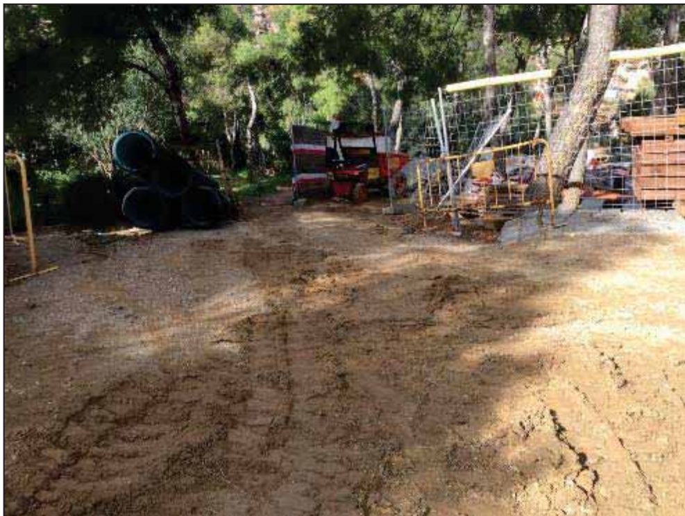
31. Zona on es realitza la rasa nord.
