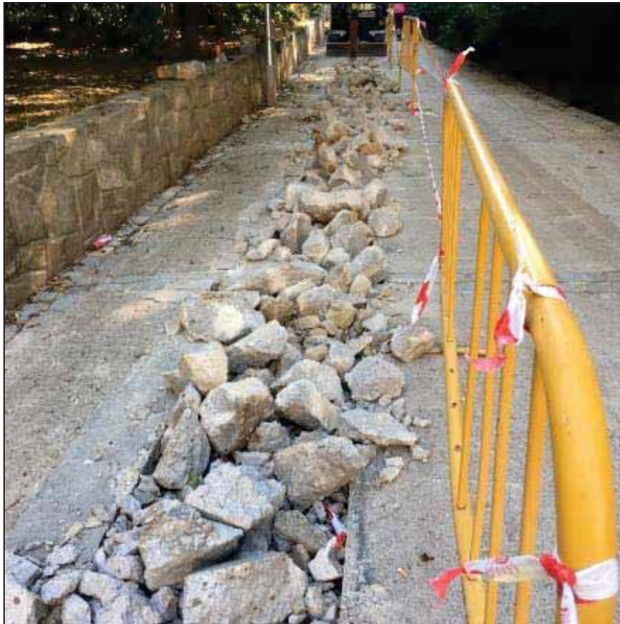
11. Imatge de l'obertura del formigó de l'actual camí d'accés al Park Güell, per a realitzar-hi la rasa.
