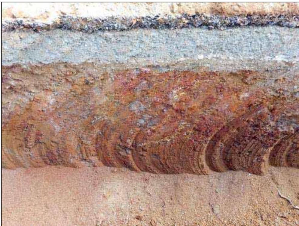
15. Tall estratigràfic del tram nord de la rasa del camp de futbol, s'aprecia el paviment de formigó, la capa d'anivellament i seguidament el terreny geològic.
