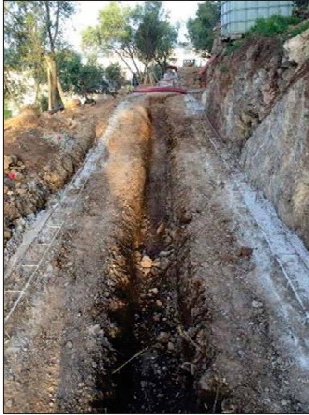
49. Realització d'una rasa UE1028 al camí de nova creació per a passar serveis.
