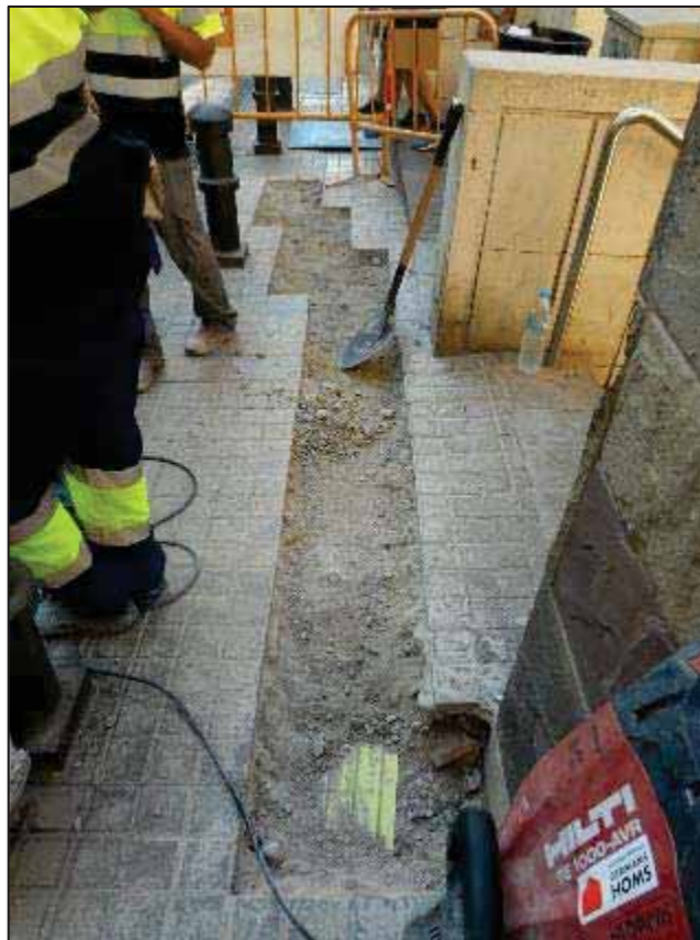
34. Treballs d'obertura en rasa al carrer de Sostres.
