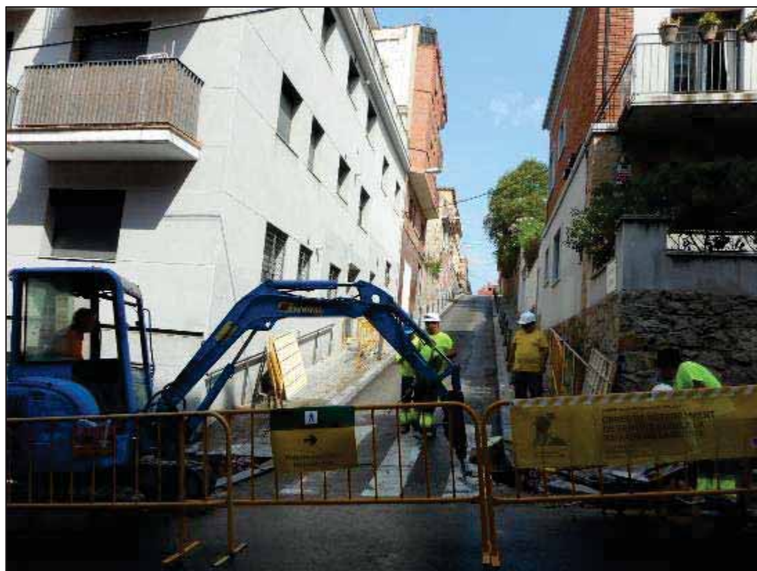
6. Treballs d'obertura en rasa del creuament al passatge d'Espíria.
