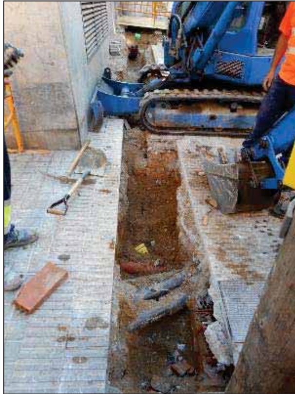
21. Treballs d'obertura en rasa a la Baixada de la Glòria, a la cantonada del carrer de la Mare de Déu del Coll.
