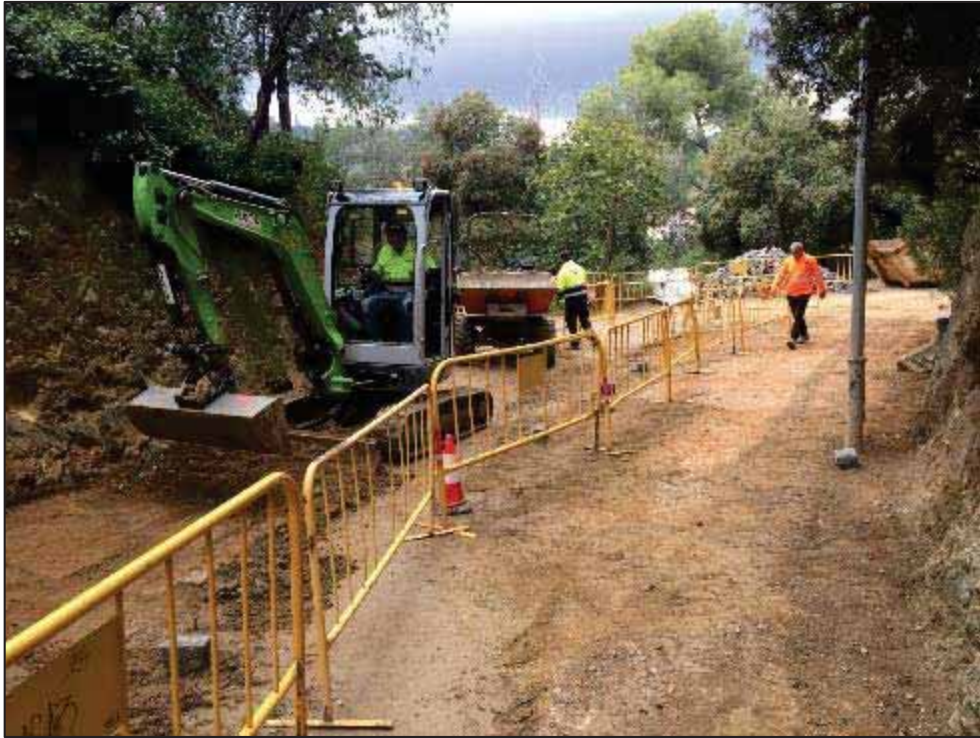
6. Màquina rebaixant terreny del Forat del Vent.
