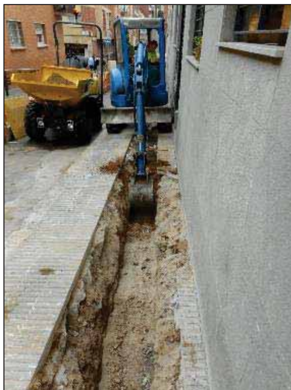
15. Treballs d'obertura en rasa a la Baixada de la Glòria, entre el passatge d'Espíria i el carrer de la Mare de Déu del Coll.
