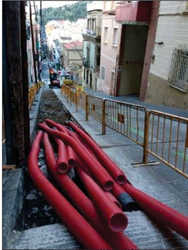
53. Rasa amb el paviment extret vista des de dalt (d'esquenes al Park Güell)
